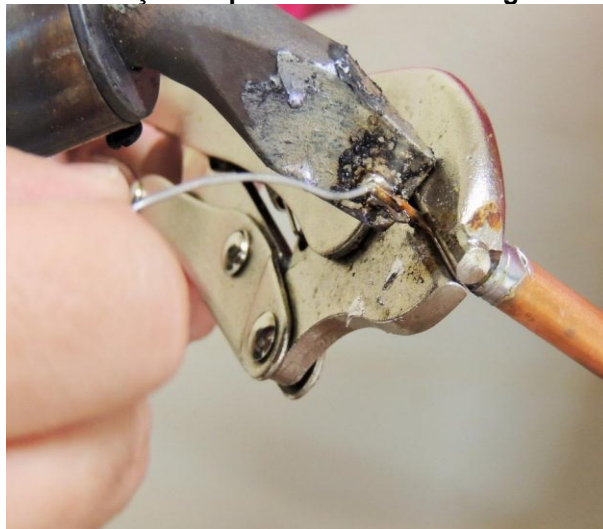
Figura 10 - Demonstração do procedimento de selagem do termossifão.
