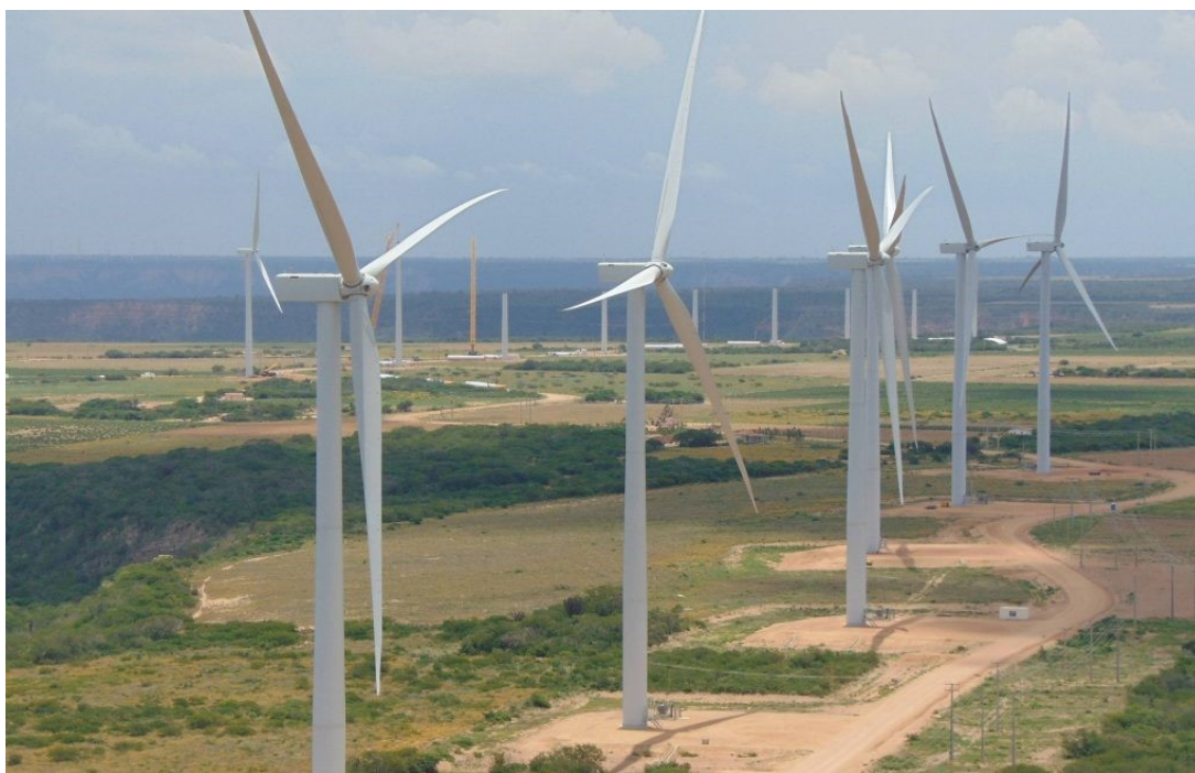
Figura 12 – Parque Eólico Chapada do Araripe, divisa entre Pernambuco e Piauí
