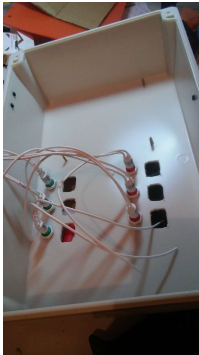
Figura 36 - Cortes, furos e fixação dos componentes do painel
