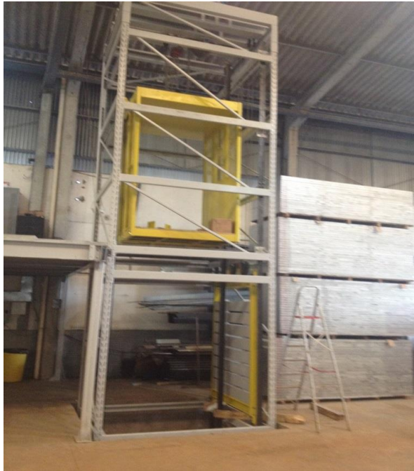
Figura 1 Elevador de carga em processo de montagem
