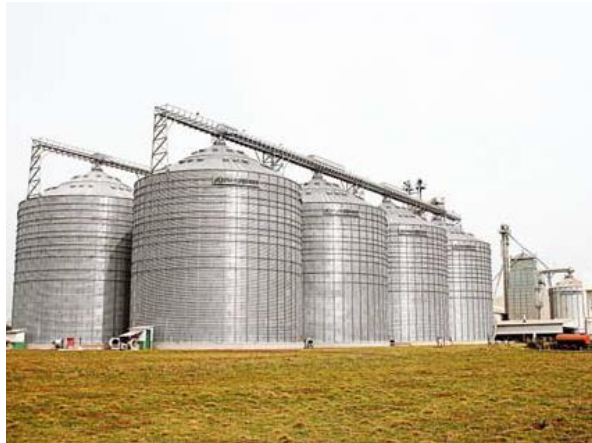
Figura 11 - Bateria de silos Fonte: Kepler Weber (2014).
