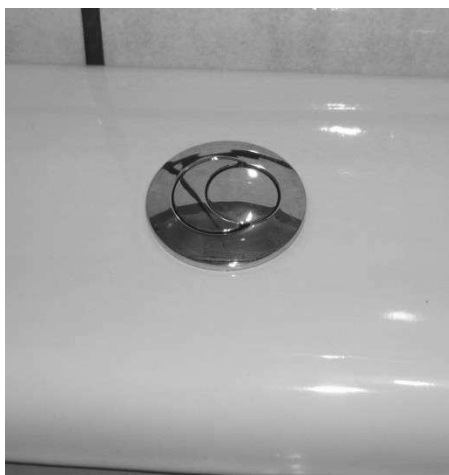
Figura 21: Vaso sanitário caixa acoplada com acionamento duplo.
