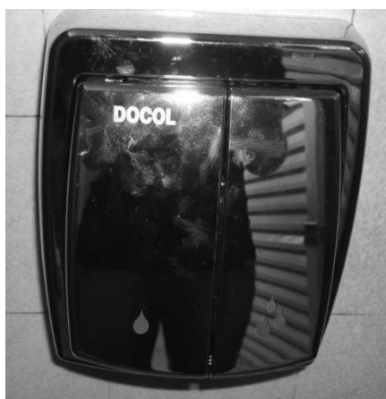
Figura 22: Bacia sanitária válvula de descarga com acionamento duplo.
