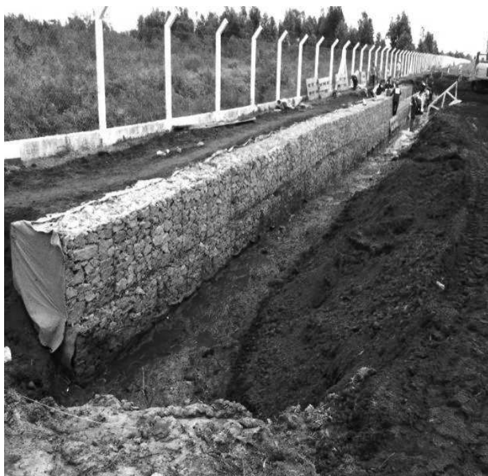
Figura 2.16 - Muro de gravidade construído com gabiões Fonte: PATRICIO (2013).
