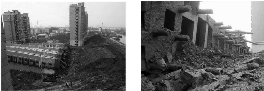
Figura 1.1 - Imagens do desabamento do prédio em Xangai. a) Vista panorâmica e b) Danos às estacas
