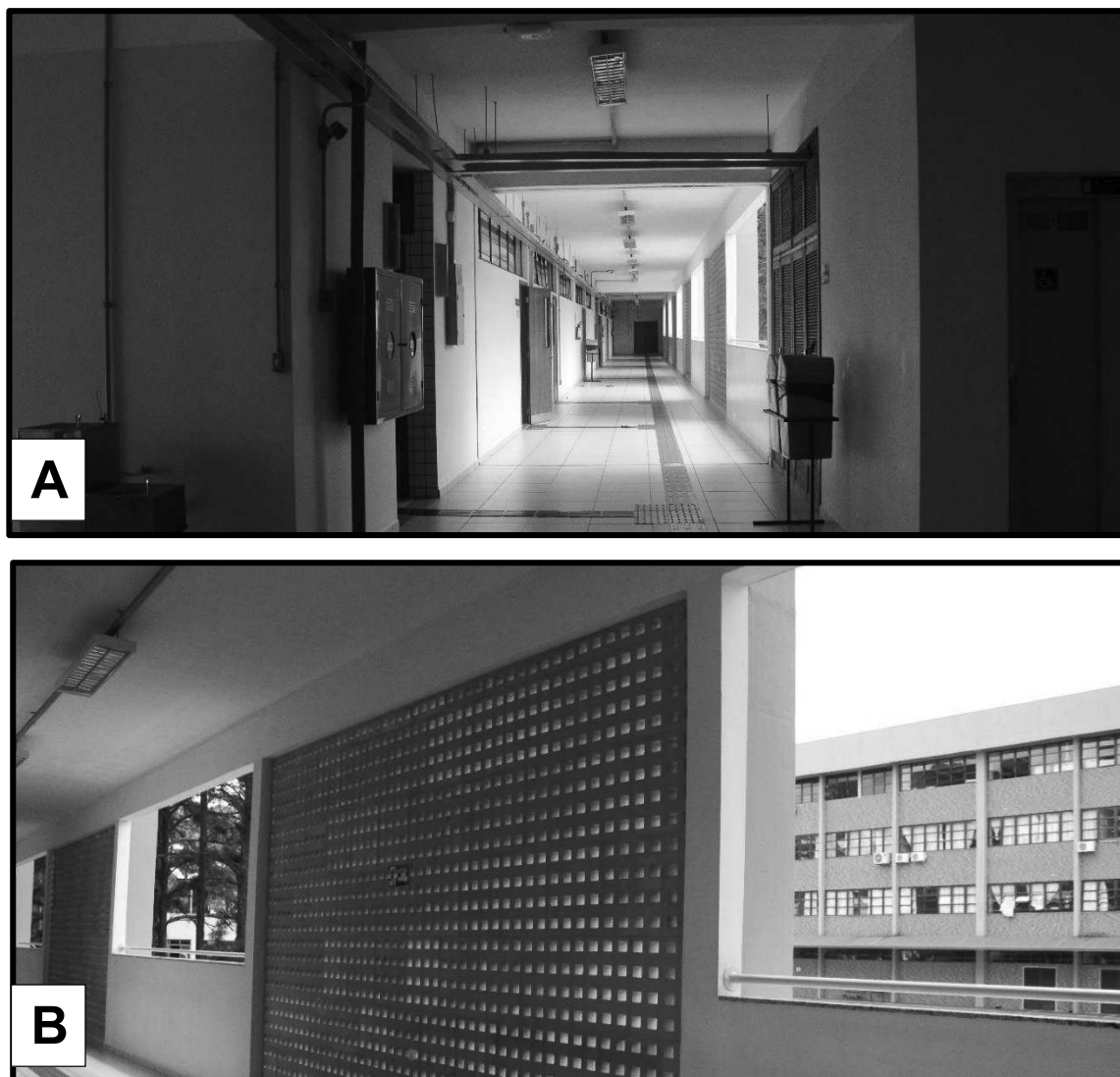
Figura 11- Corredor primeiro andar. (A) Vista corredor. (B) Detalhe das aberturas do corredor Fonte: Autora, 2016.
