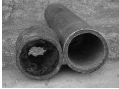
Figura 9- Tubulação pré e pós reabilitação
