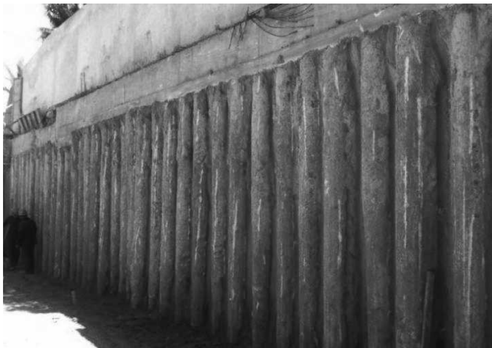
Figura 2 – Cortina de contenção em divisa de terreno. Fonte: AGM geotécnica.
