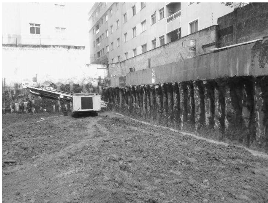
Figura 1 – Cortina de contenção em divisa de terreno Fonte: Tecnisa, 2014.
