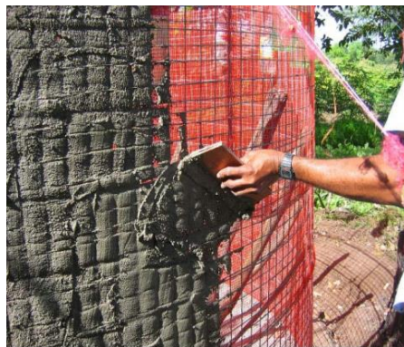
Figura 5 – Aplicação da primeira camada de argamassa na estrutura de uma cisterna Fonte: Schistek (2005, p. 4).
