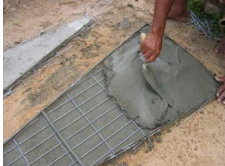
Figura 6 – Execução das placas para a parte superior Fonte: Schistek (2005, p. 5).
