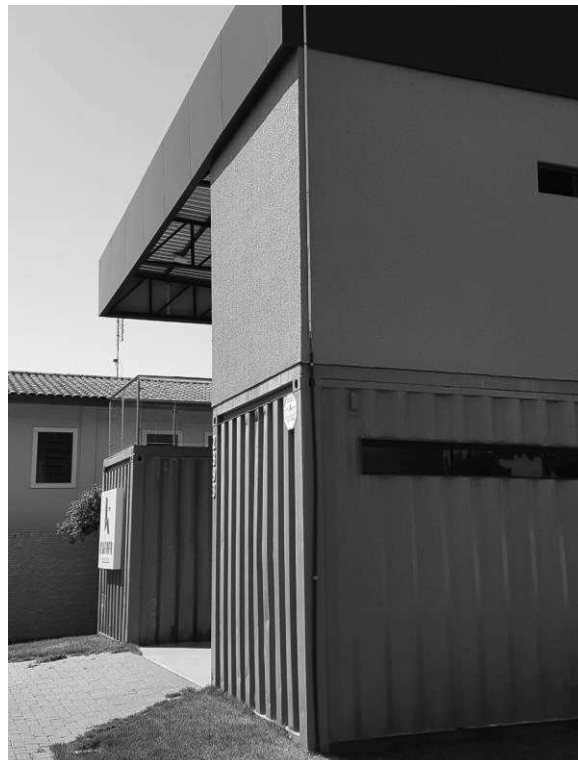
Figura 32 – Vista do aterramento da estrutura Fonte: Autoria Própria, 2017.
