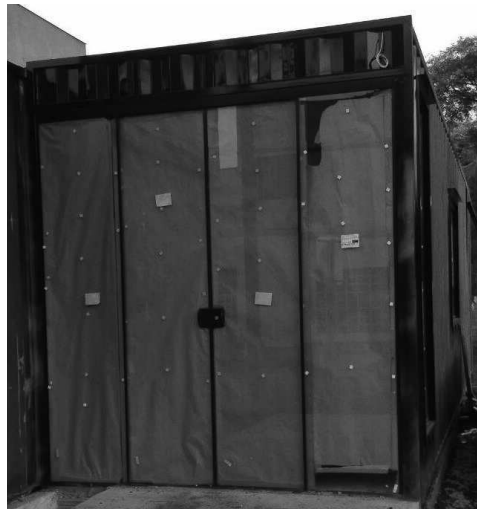
Figura 27 – Abertura de vão para a colocação de uma porta de correr Fonte: Aatoria Própria, 2017.
