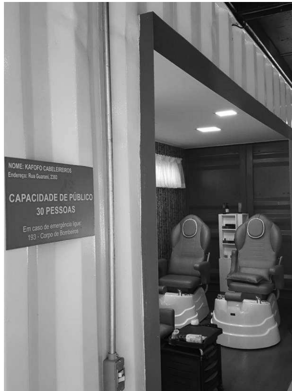
Figura 33 – Reforço estrutural na abertura do vão Fonte: Autoria Própria, 2017.
