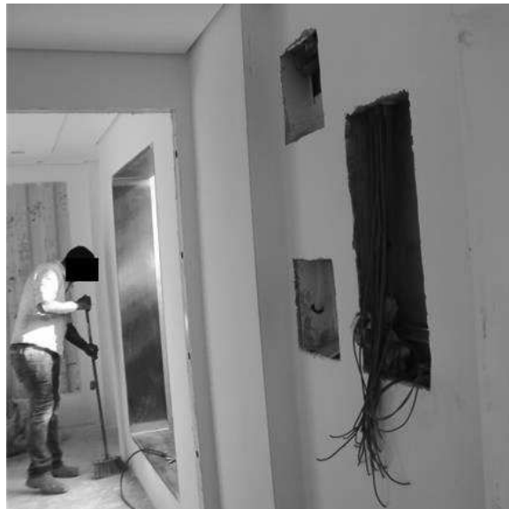
Figura 26 – Quadros de distribuição elétrico e telefônico Fonte: Autoria Própria, 2017.
