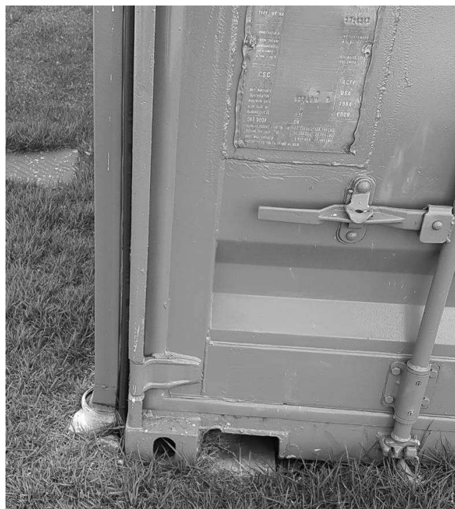
Figura 35 – Contêiner apoiado sobre a fundação Fonte: Autoria Própria, 2017.
