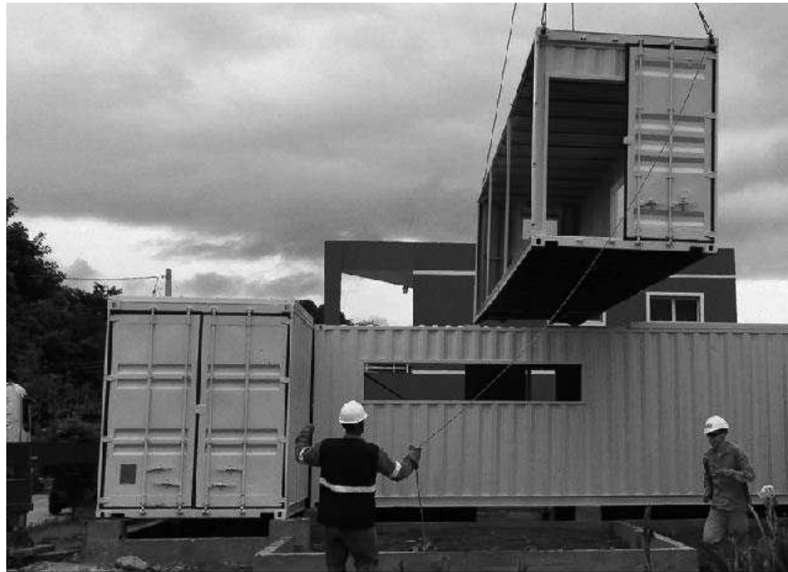
Figura 9 – Obra de contêiner durante a execução Fonte: Revista Técnica (2013).
