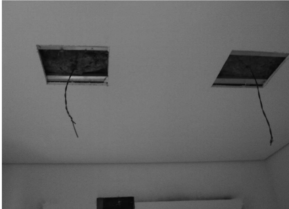
Figura 23 – Execução do isolamento térmico e acústico Fonte: Autoria Própria, 2017.
