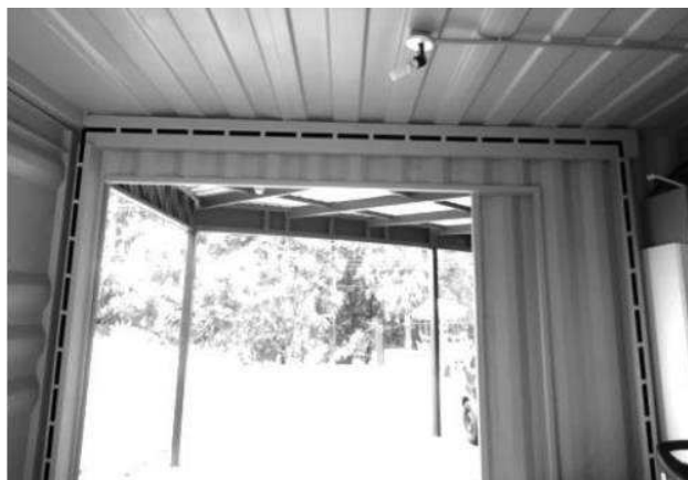
Figura 6 – Deformação e reforço da estrutura do contêiner.
