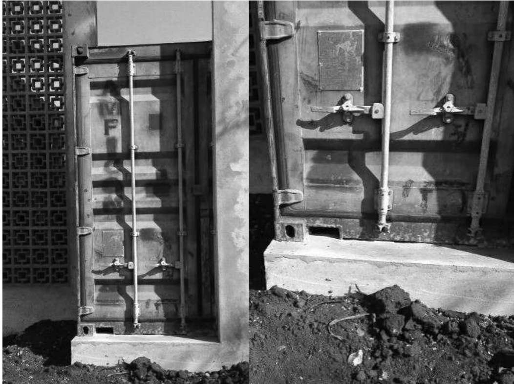
Figura 29 – Vedação da porta de abertura de um contêiner Fonte: Autoria Própria, 2017.
