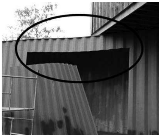
Figura 6 – Deformação e reforço da estrutura do contêiner.
