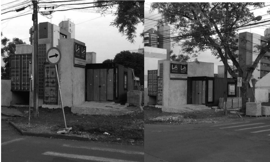
Figura 22 – Fachada da obra em execução Fonte: Autoria Própria, 2017.
