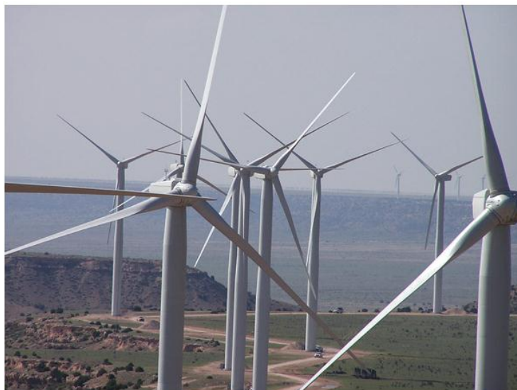
Figura 6 - Turbina Eólica de eixo horizontal produzida pela empresa Tecsis – Sorocaba – Brasil Fonte: http://www.tecsis.com.br/site/wind.php
