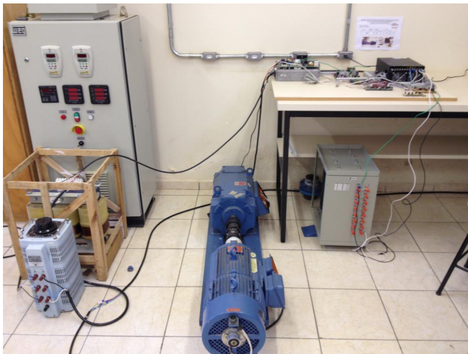
Figura 95 - Sistemas montado em laboratório para operação do sistema como gerador Fonte: Autoria Própria
