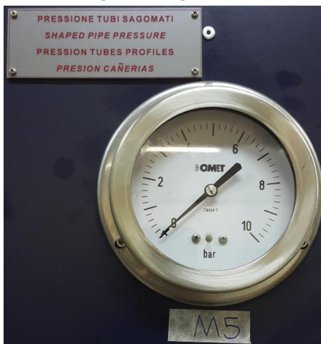
Figura 33 - Manômetro de Bourdon (M 5 ), para medir a pressão acima dos tubos perfilados.
