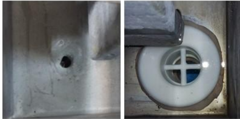
Figura 9 – Comparativo furo de saída da bancada inicialmente e após a modificação
