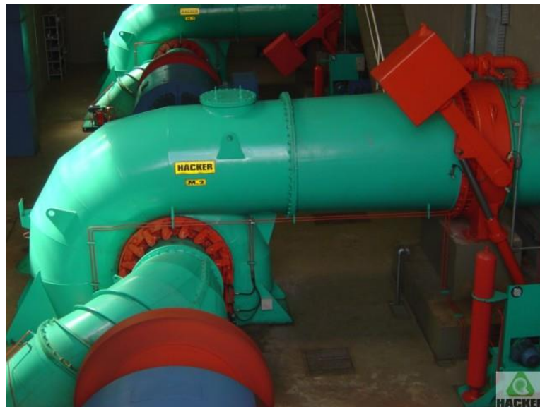
Figura 4 – Turbina Francis. Fonte: Extraído de (HACKER INDUSTRIAL LTDA, 2017).
