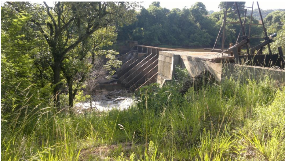
Figura 15 – Barragem CGH Fonte: Autoria Própria.
