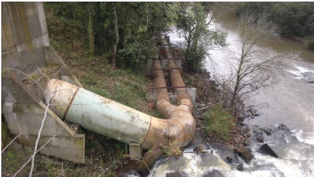
Figura 12 – Tubulação Forçada Anterior a Reforma. Fonte: Autoria Própria.
