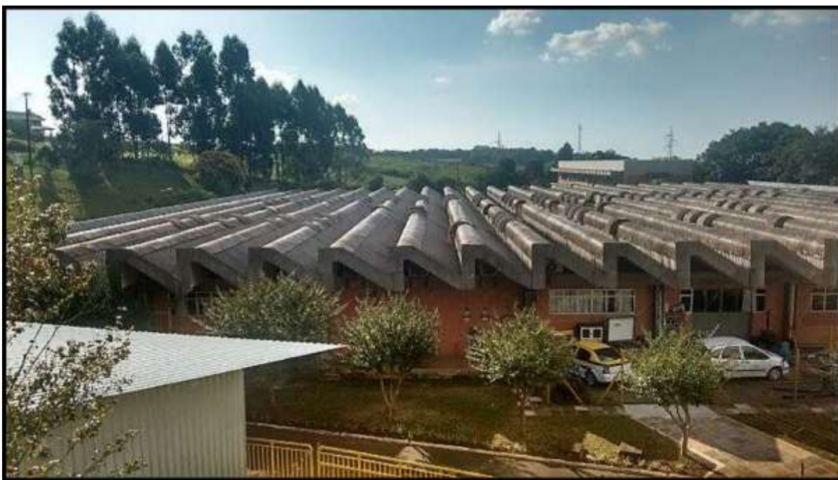
Figura 24 - Estrutura do telhado bloco HIJ UTFPR-PB. Fonte: Autoria própria
