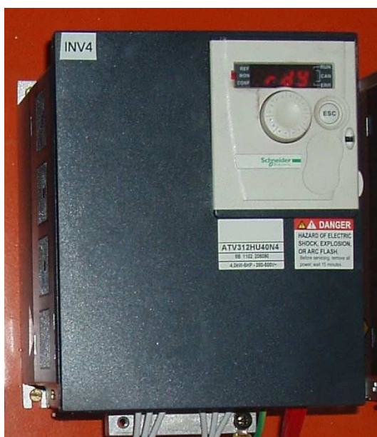
Figura 8: Inversor de frequência Altivar 31.
