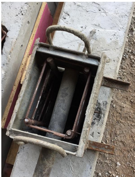
Figura 43 - Fôrma dos consoles.
