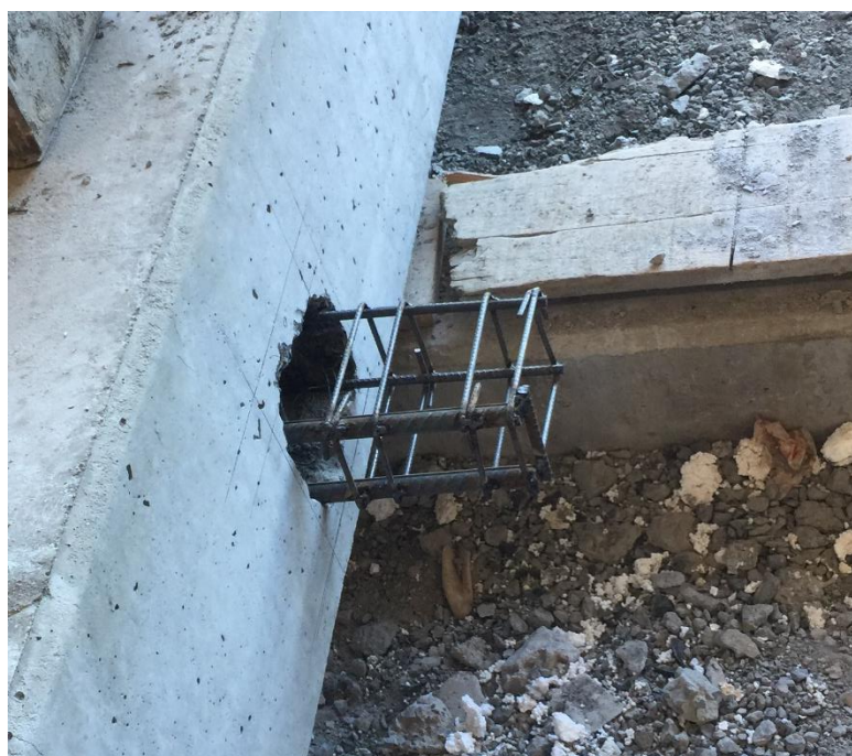
Figura 42 – Armadura do console posicionada.
