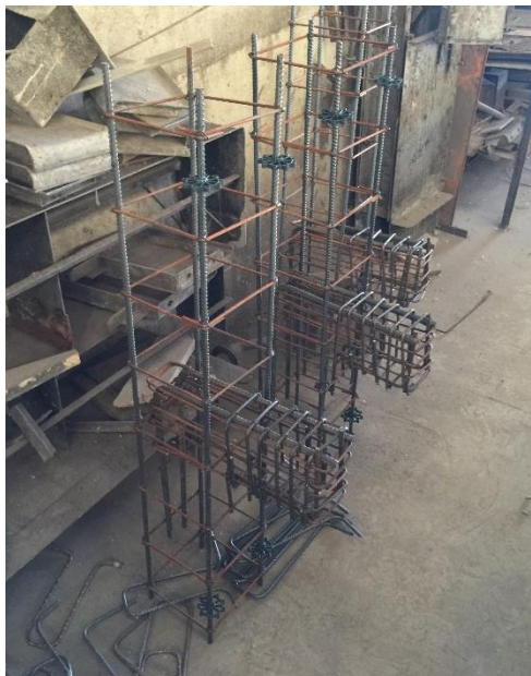
Figura 46 - Armadura dos consoles segundo a NBR 9062:2017.
