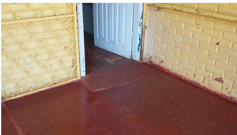
Figura 38 - Acesso a Sala de Aula Fonte: Autoria Própria (2016)
