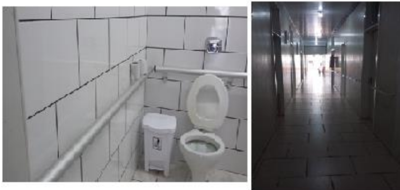
Figura 49 - Sanitário Acessível Fonte: Autoria Própria (2016)
