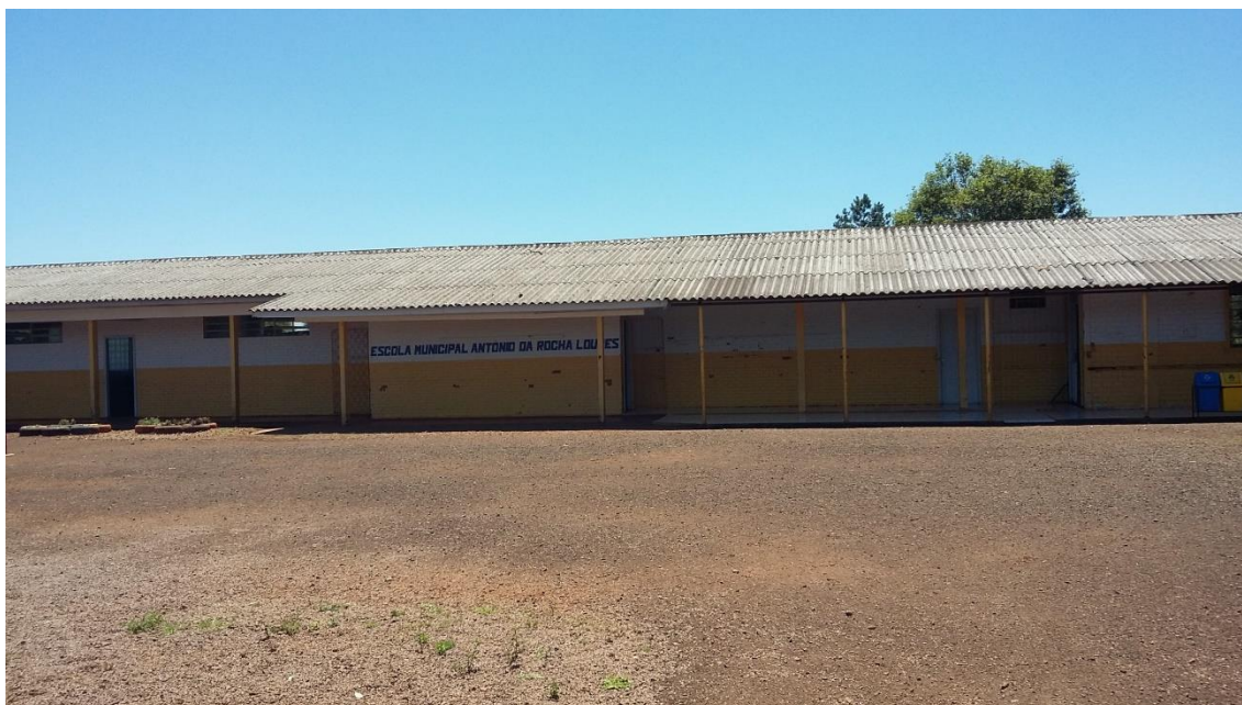
Figura 36 - Escola Municipal Antônio Rocha Loures Fonte: Autoria Própria (2016)
