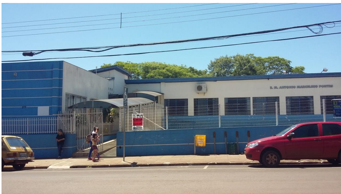
Figura 45 - Escola Municipal Antônio Marcelino Pontes Fonte: Autoria Própria (2016)
