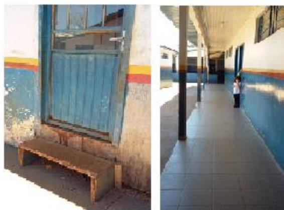
Figura 44 - Acesso a sala de aula Fonte: Autoria Própria (2016)
