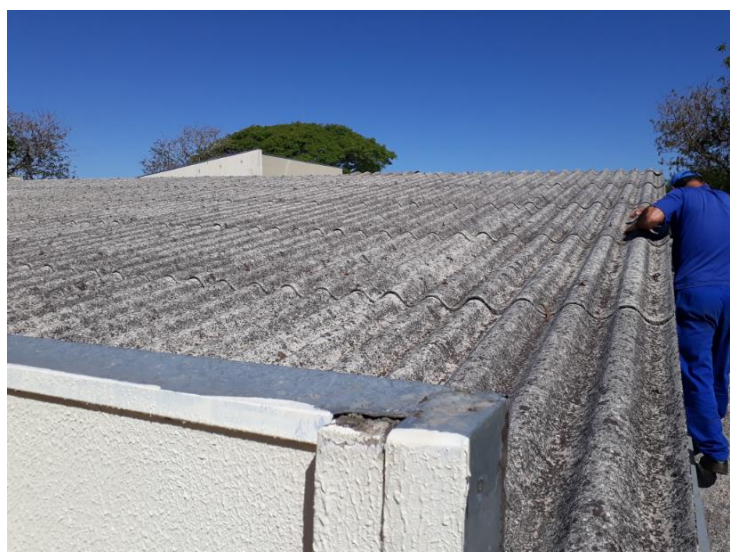
Figura 8: Exemplo telhado cimento amianto na UTFPR Pato Branco Fonte: Autoria própria (2017)
