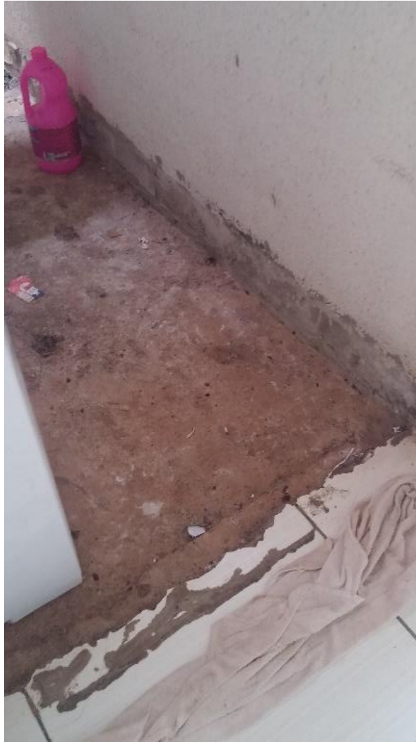
Figura 35 - Piso Lavanderia Fonte: Autor (2017)
