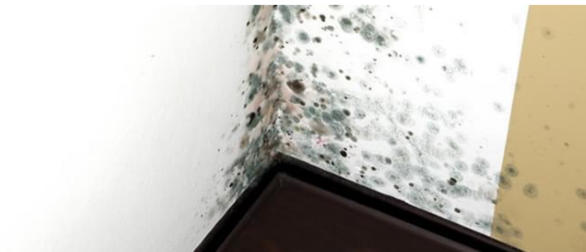
Figura 19 - Bolor em parede Fonte: AECWeb (2017).
