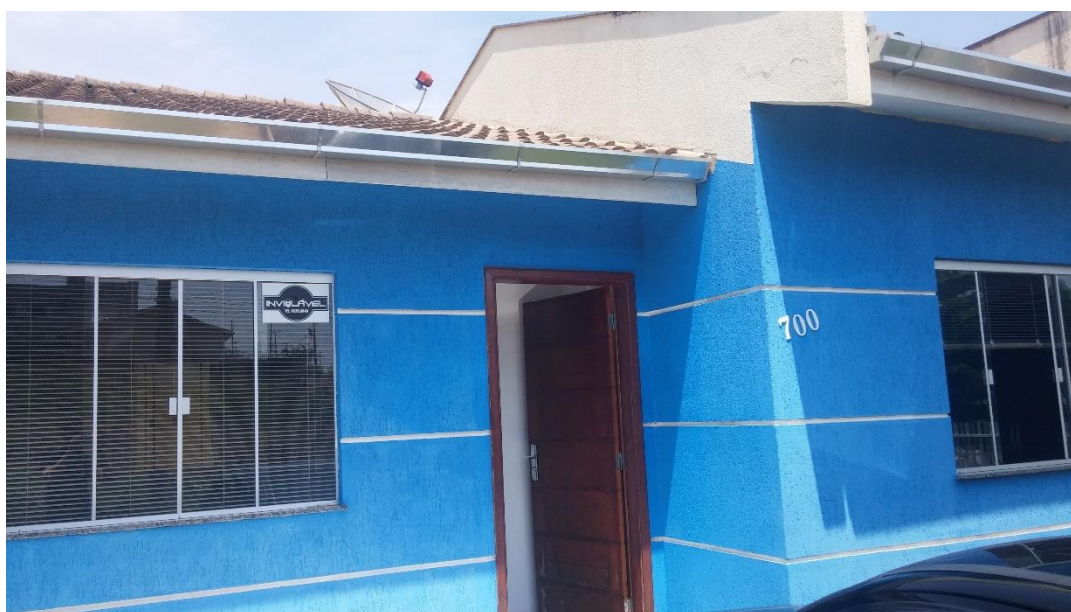
Figura 43 - Fachada da Residência 3 Fonte: Autor (2017)
