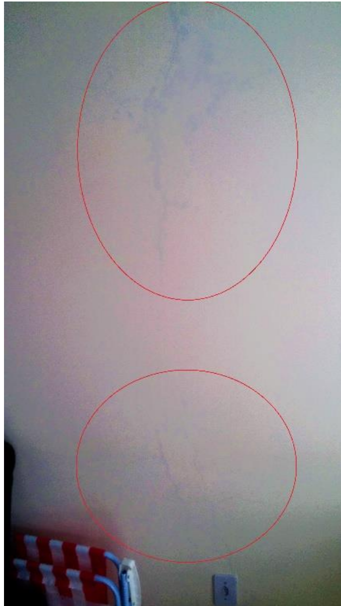
Figura 27 - Bolhas e descoloração Fonte: Autor (2017)
