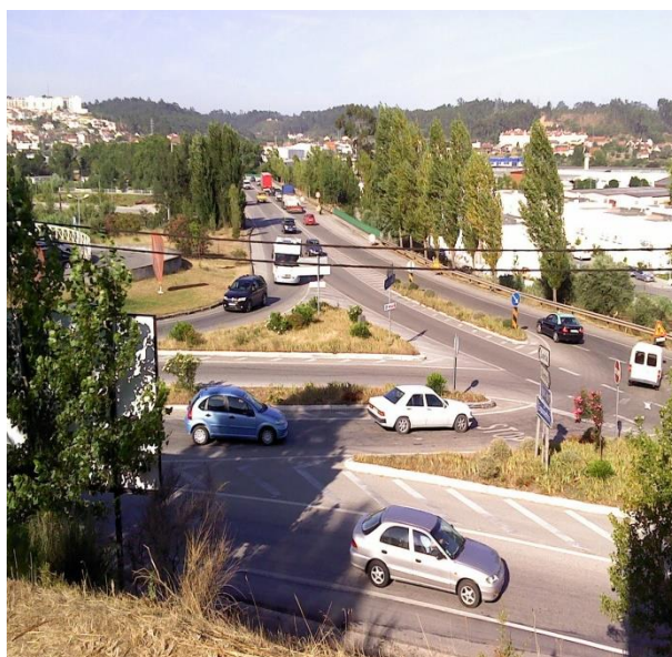
Figura 2 - Interseção canalizada I Fonte: Sérgio Pombal (2001).
