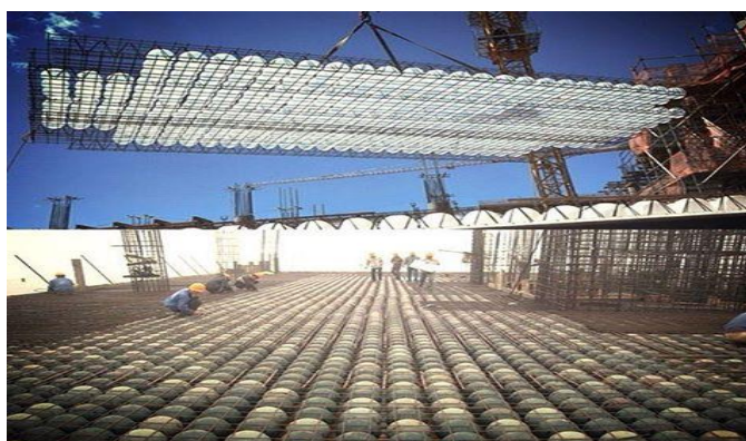
Figura 7- Módulos Bubbledeck Fonte: Bubbledeck Internacional
