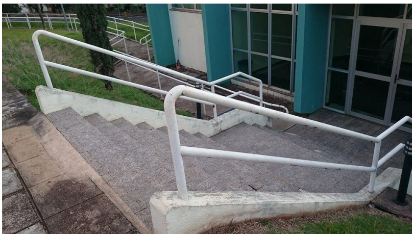
Fotografia 11 – Escada de acesso a entrada lateral Fonte: a autora, 2015
