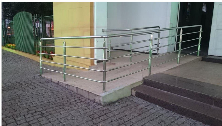
Fotografia 08 – Rampa de acesso: Igreja Matriz Católica Fonte: a autora, 2015
