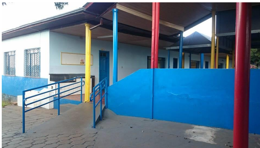
Fotografia 10 – Rampa de acesso a sala de aula Fonte: a autora, 2015
