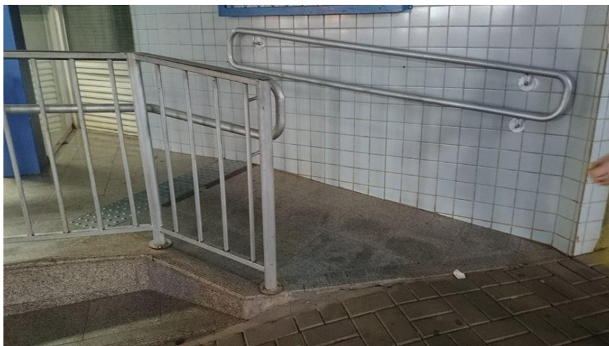
Fotografia 16 – Corrimão: Caixa Econômica Fonte: a autora, 2015
