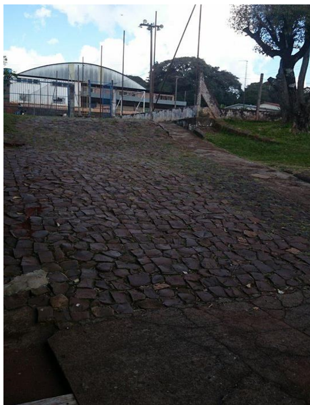
Fotografia 27 – Acesso ao ginásio de esportes: Colégio La Salle Fonte: a autora, 2015
