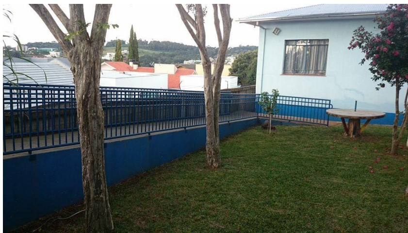
Fotografia 09 – Acesso ao pátio: Colégio La Salle Fonte: a autora, 2015
