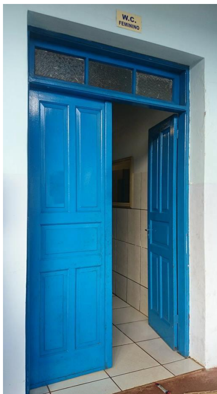
Fotografia 21 – Porta do banheiro: Colégio La Salle Fonte: a autora, 2015
