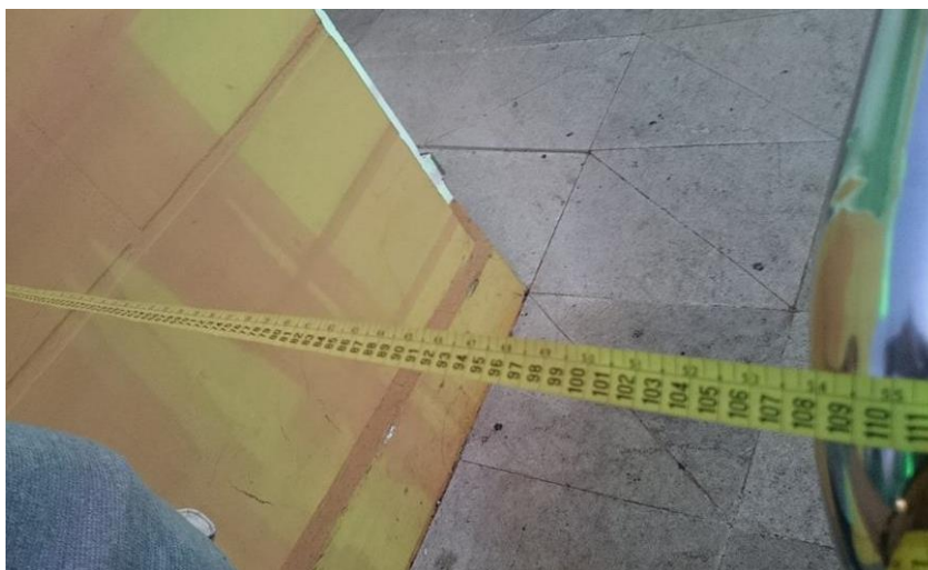
Fotografia 07 – Rampa de acesso: Igreja Matriz Católica Fonte: a autora, 2015
