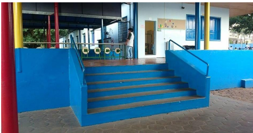
Fotografia 15 – Escada de acesso a cantina Fonte: a autora, 2015
