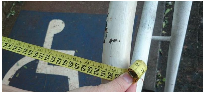
Fotografia 05 – Rampa de acesso da entrada secundária Fonte: a autora, 2015
