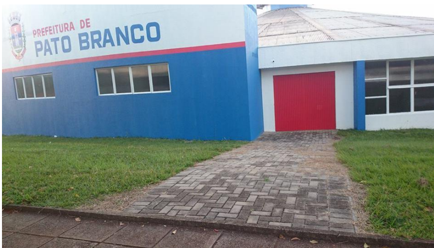
Fotografia 22 – Acesso de entrada ao Ginásio de Esportes Fonte: a autora, 2015
