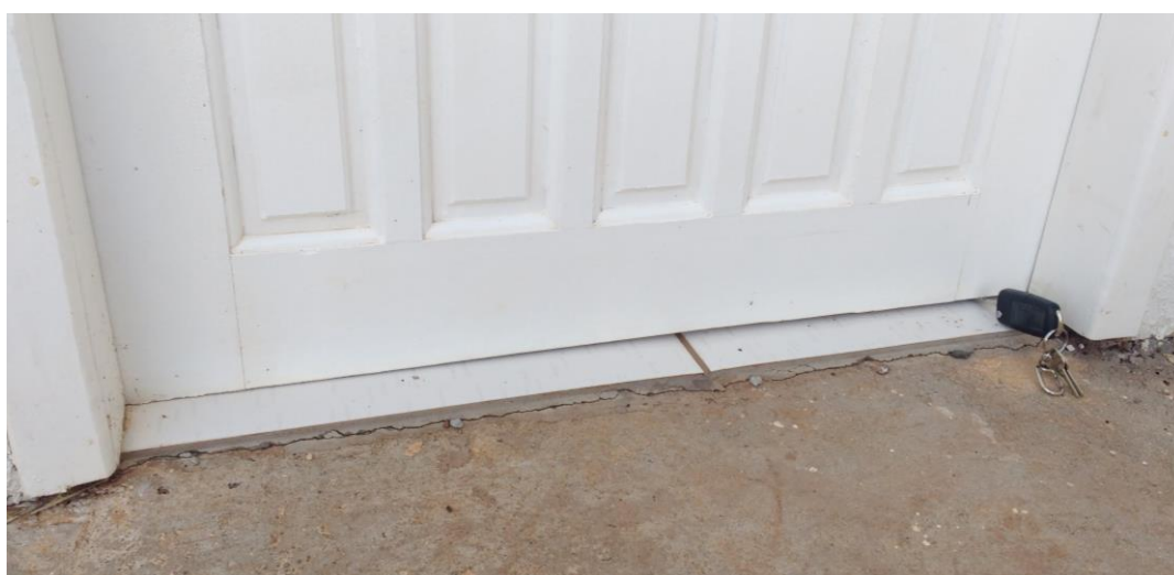
Figura 23 - Fresta na porta de entrada Fonte: Autoria própria (2017).
