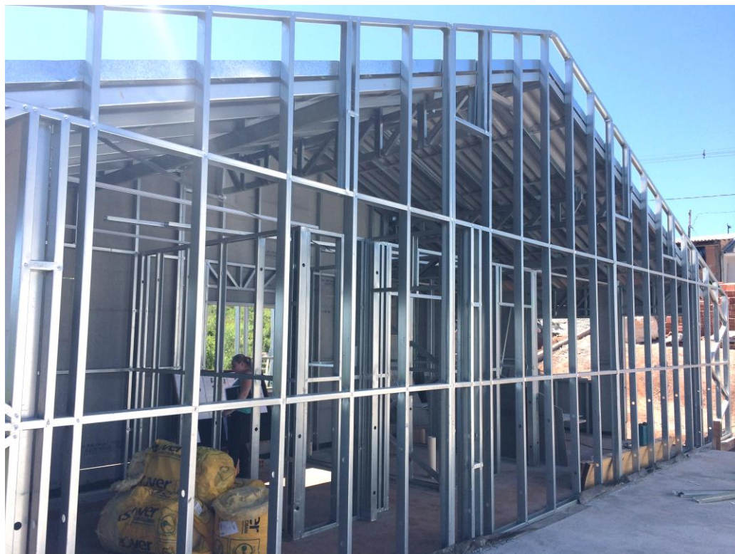
Figura 20 - Detalhes construtivos da residência em LSF Fonte: FRONTER (2017).
