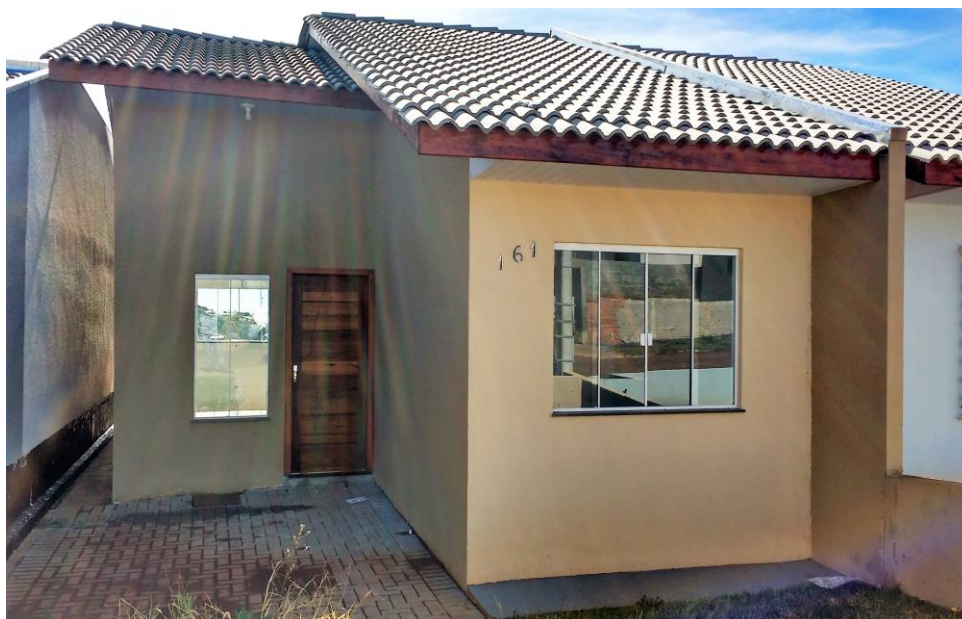
Figura 17 - Fachada da residência em Alvenaria Convencional Fonte: Autoria própria (2017).
