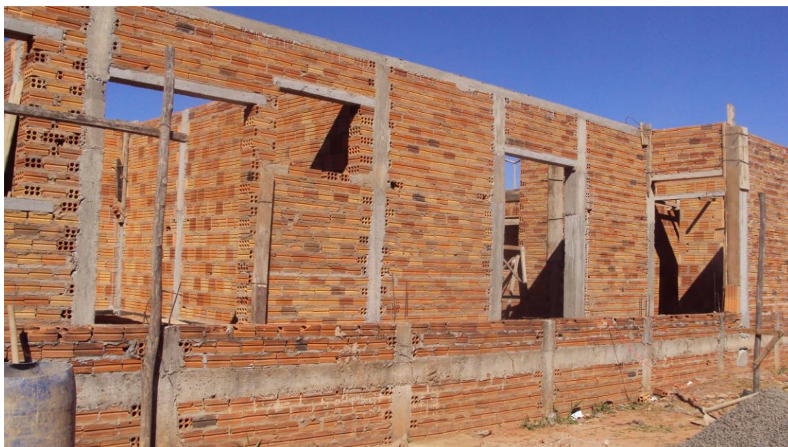
Figura 1 - Obra executada em sistema de alvenaria convencional Fonte: Alfonsi Construções (2016).
