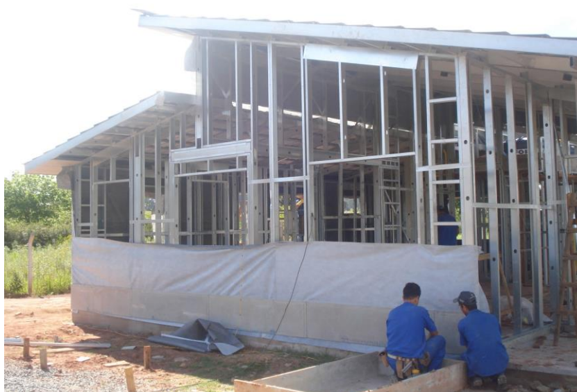
Figura 5 - Aplicação da membrana sobre a estrutura em LSF Fonte: Adaptado do manual de vedação Brickawall .
