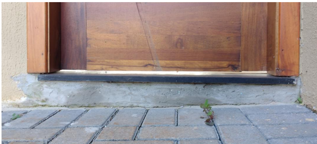
Figura 22 - Fresta na porta de entrada Fonte: Autoria própria (2017).
