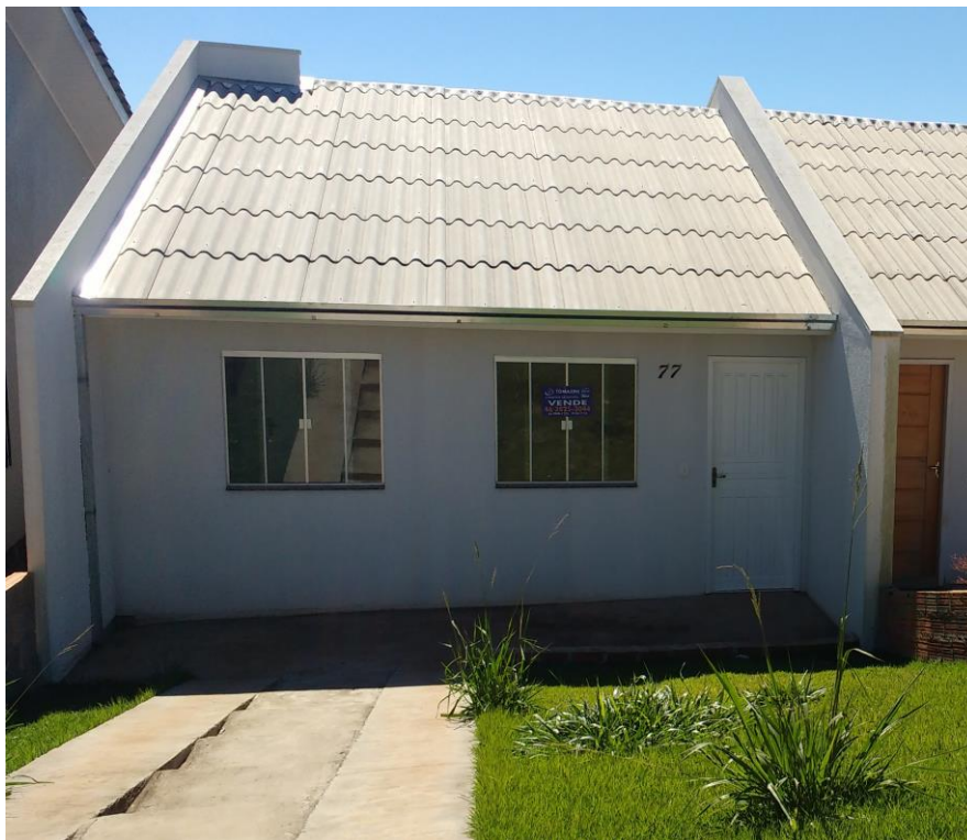
Figura 16 - Fachada da residência em LSF Fonte: Autoria própria (2017).
