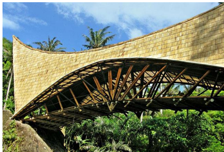
Figura 13: Ponte construída com vigas de bambu - Indonésia Fonte: Pequenas empresas Grandes negócios(2012)
