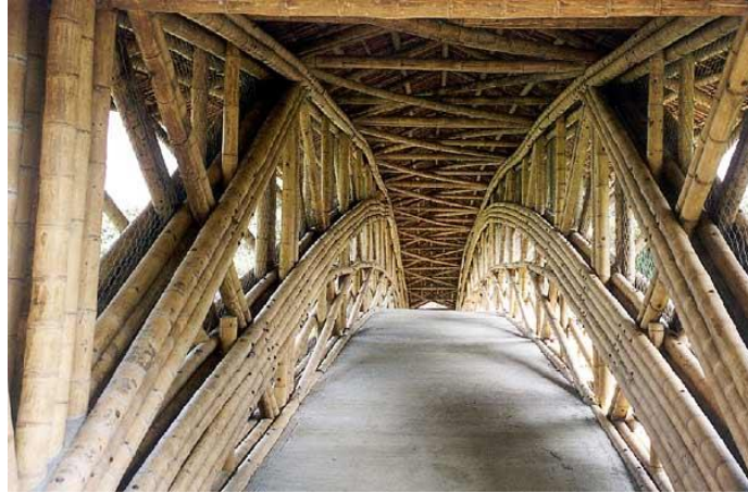
Figura 14: Detalhes da estrutura de ponte em bambu - Indonésia Fonte: STAMM(2016)
