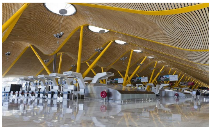
Figura 26: Cobertura do aeroporto de Barajas - Espanha Fonte: Corbo (2015)
