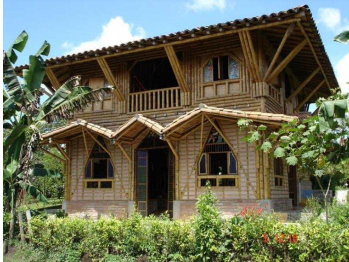
Figura 11: Casa feita em bambu - Colômbia Fonte: Arquitetura Sustentável (2012)
