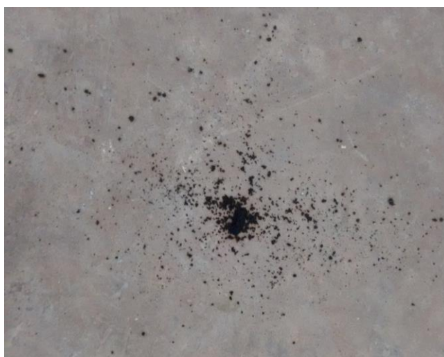
Figura 33 - Teste de verificação da mistura para solo-cimento Fonte: Acervo Pessoal (2017).
