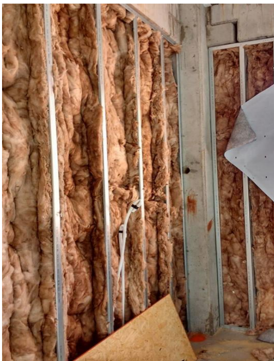
Figura 25 – Lã de vidro preenchendo o vão entre as placas de fechamento Fonte: Arquivo da autora.
