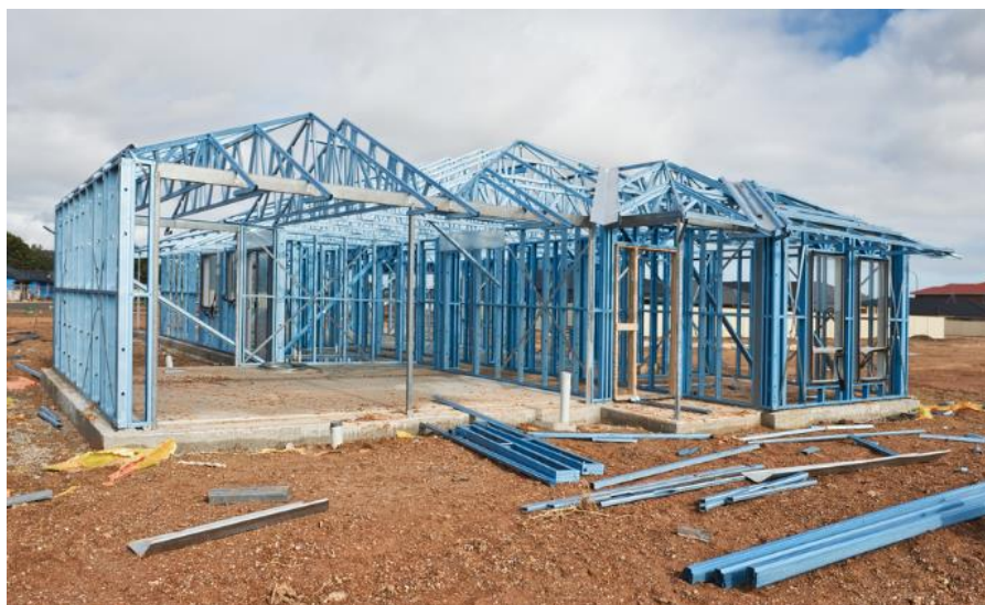
Figura 4 – Construção em LSF Fonte: GDK, 2016.
