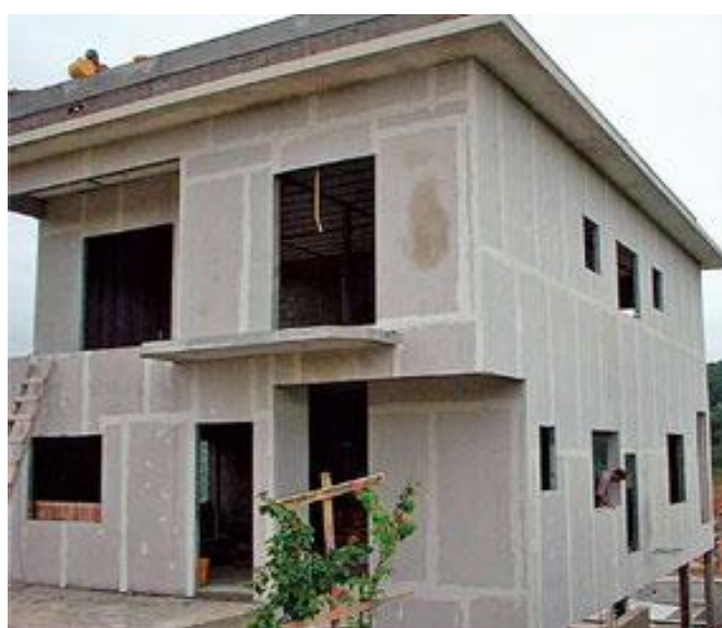
Figura 24 – Casa construída com placas cimentícias Fonte: Franco, 2010.
