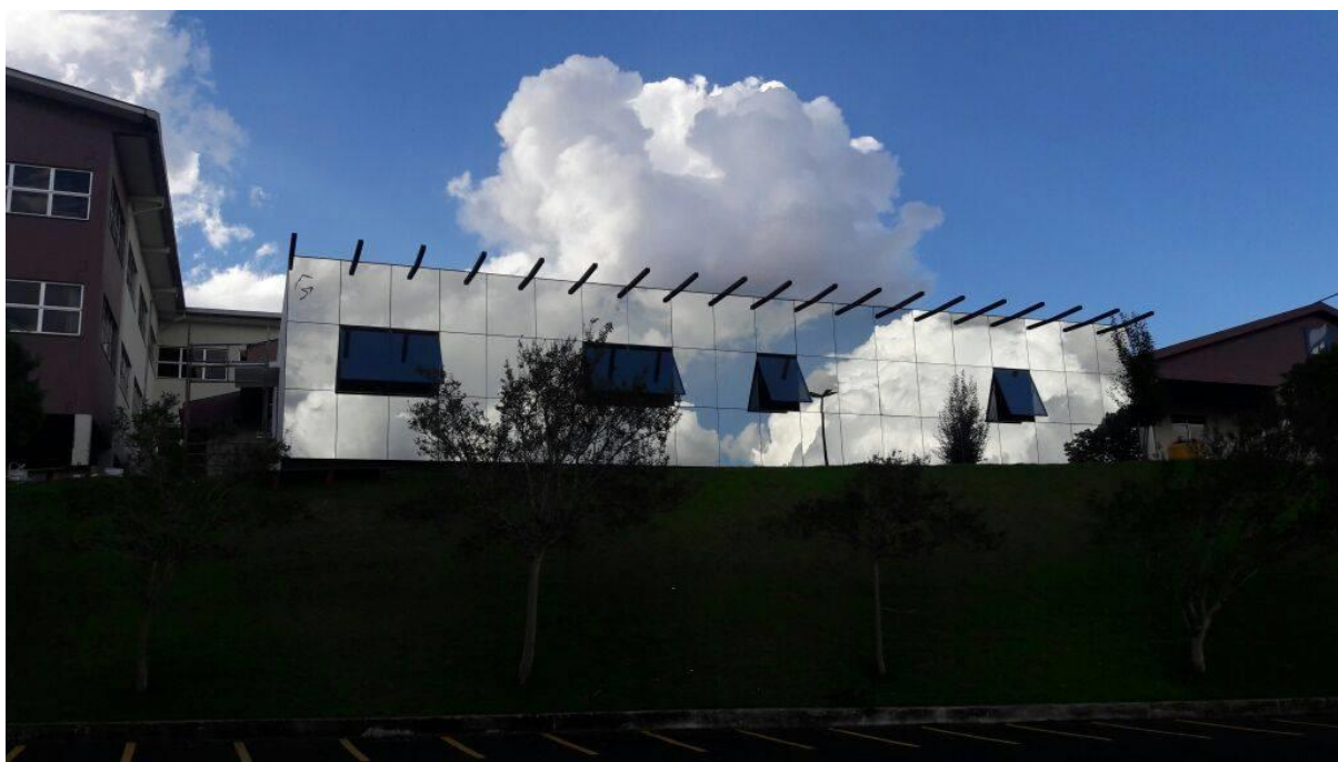
Figura 31- Bloco construído na FADEP
