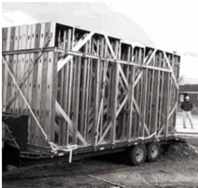
Figura 7 – Painéis pré-fabricados sendo levados à obra Fonte: Santiago, Freitas e Crasto, 2012.
