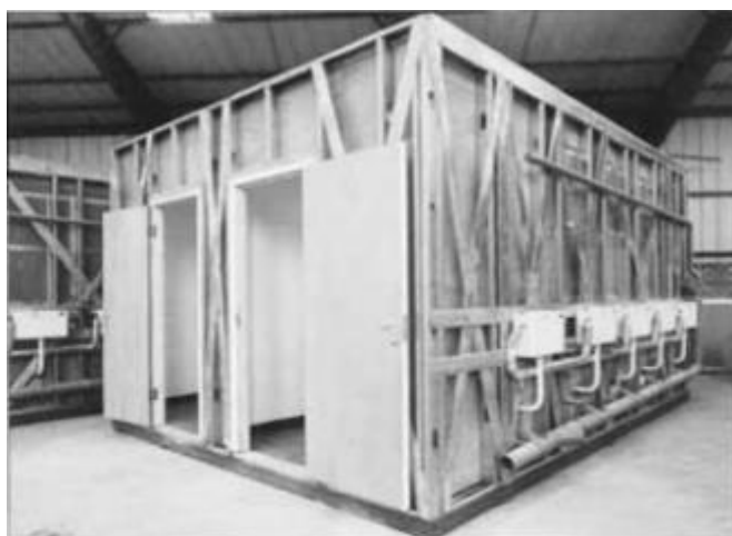
Figura 8 – Módulo de banheiro Fonte: Santiago, Freitas e Crasto, 2012.
