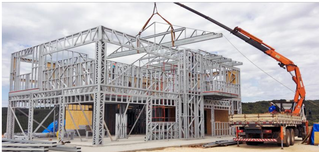
Figura 27 – Posicionamento de tesoura em uma estrutura em LSF Fonte: SMART Sistemas Construtivos, 2016.
