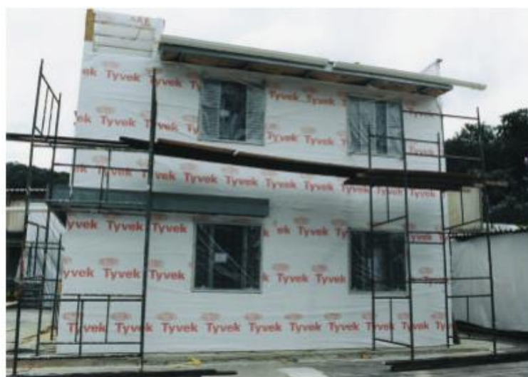
Figura 23 – Impermeabilização das placas de OSB com membrana de polietileno Fonte: Crasto, 2005.
