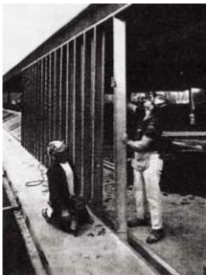
Figura 6 –Montagem do sistema pelo método Stick Fonte: Santiago, Freitas e Crasto, 2012.
