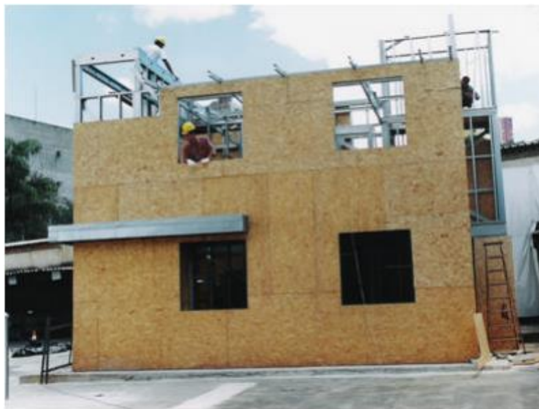
Figura 22 – Fachada com fechamento externo em OSB Fonte: Crasto, 2005.
