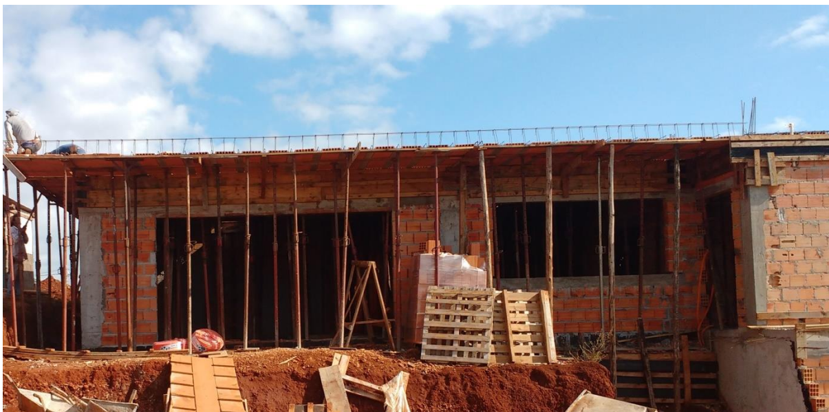
Figura 1- Construção pelo sistema convencional Fonte: Autoria Própria, 2016.
