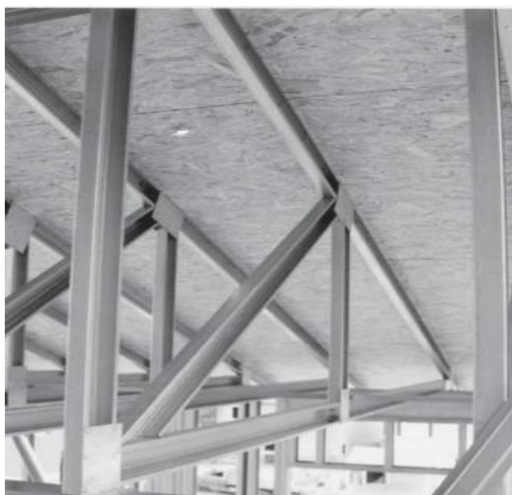
Figura 13 – Placas de OSB servindo de diafragma rígido Fonte: Santiago, Freitas e Crasto, 2012.
