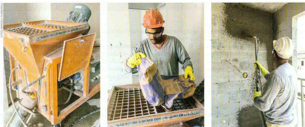
Figura 2 - Mistura e projeção de argamassas mecanicamente projetadas
