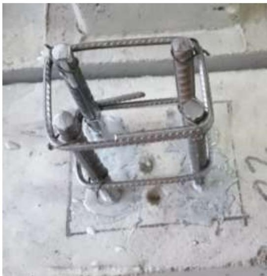
**Figura 39 – Detalhe da amarração do estribo**
