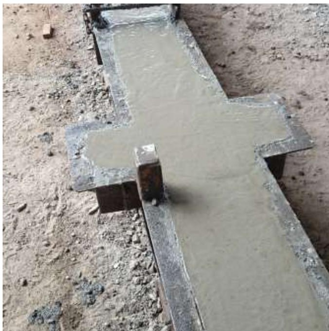
**Figura 35 - Consoles concretados juntamente com as peças**
