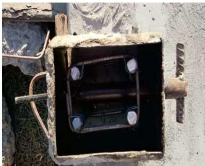
**Figura 40 – Posicionamento do molde metálico**
