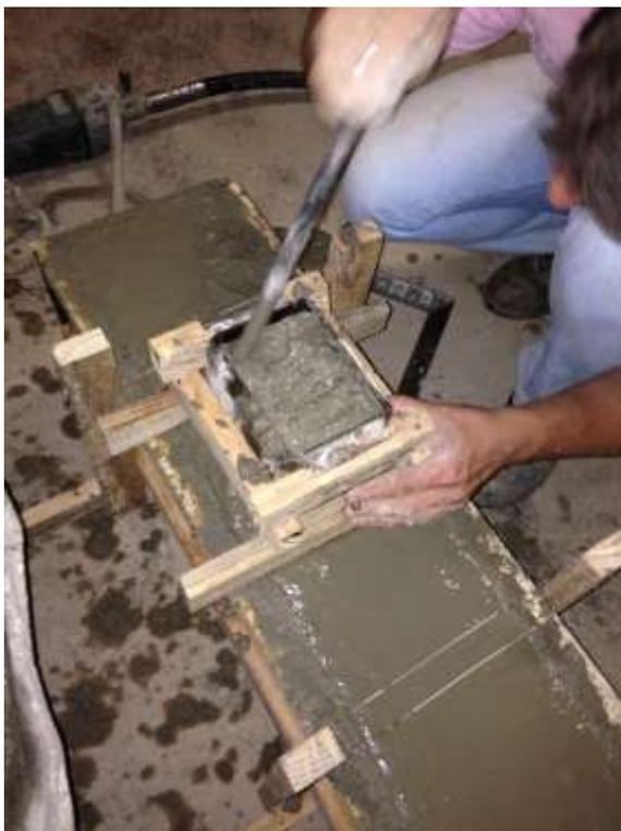
**Figura 44 – Concretagem dos elementos em etapa única**
