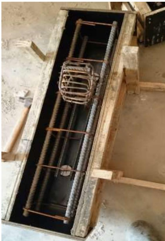
**Figura 43 – Armaduras posicionadas na fôrma**
