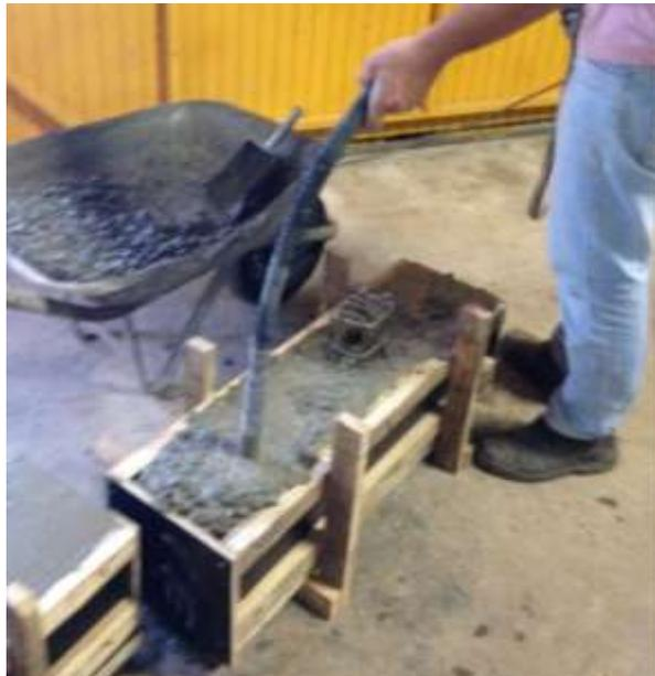
**Figura 45 – Adensamento do concreto**
