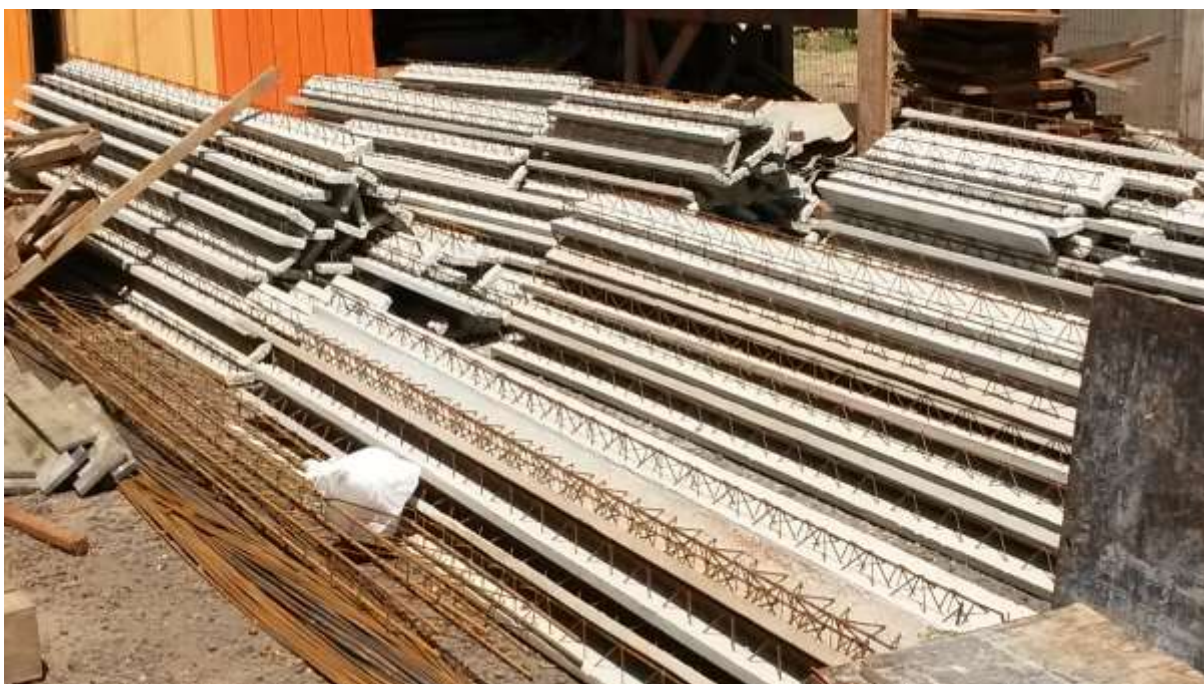
Figura 14: Vigotas no local da obra – Edifício LVPT Fonte: Adquirida pelos autores.
