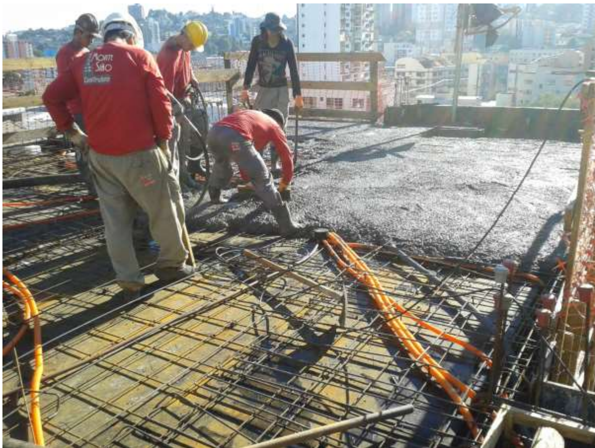
Figura 10: Lançamento e regularização do concreto Fonte: Adquirida pelos autores
