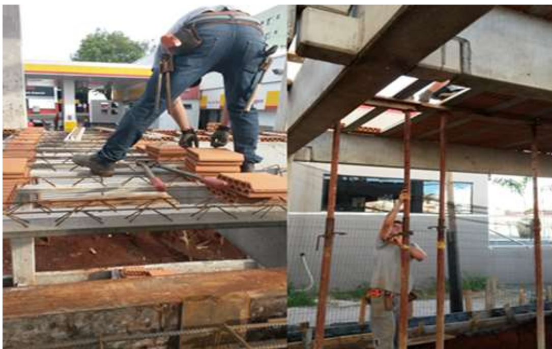
Figura 15: Instalação das vigotas com escoramentos – Edifício LVPT Fonte: Adquirida pelos autores.
