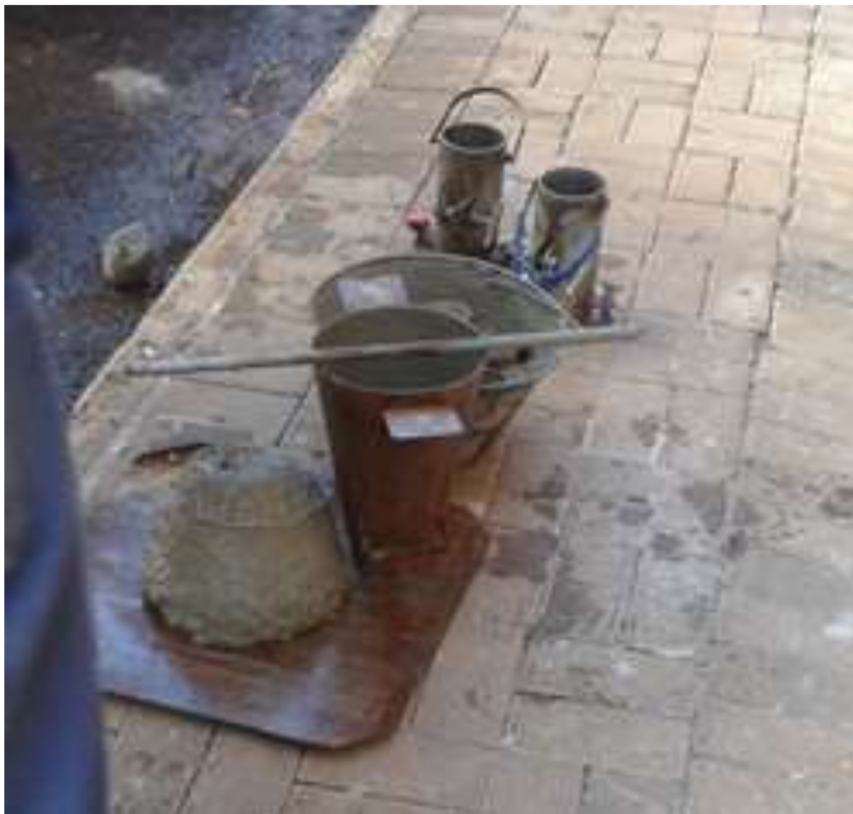
Figura 9: Slump do concreto no local da obra Fonte: Adquirida pelos autores.
