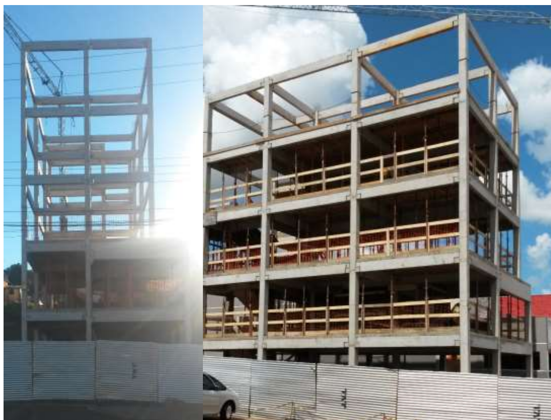
Figura 25: Edifício de LVPT em execução no município de Pato Branco-PR Fonte: Adquirida pelos autores.
