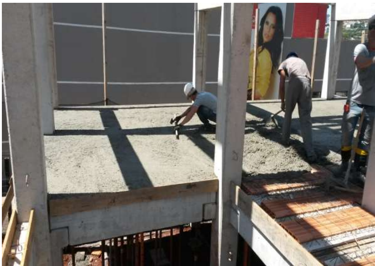
Figura 18: Concretagem e regularização – Edifício LVPT Fonte: Adquirida pelos autores.
