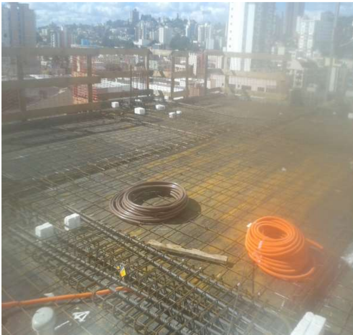
Figura 7: Armadura com espaçadores sobre fôrmas da LMS Fonte: Adquirida pelos autores.
