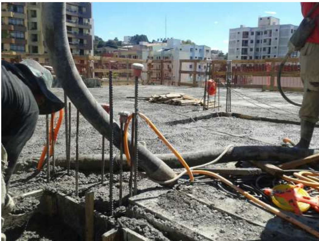
Figura 1: Concreto despejado em forma de laje maciça Fonte: Foto adquirida pelos autores.
