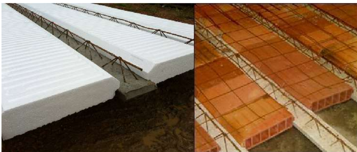
Figura 11: EPS e Tabelas para lajes de vigotas pré-fabricadas Fonte: Foto adquirida pelos autores.
