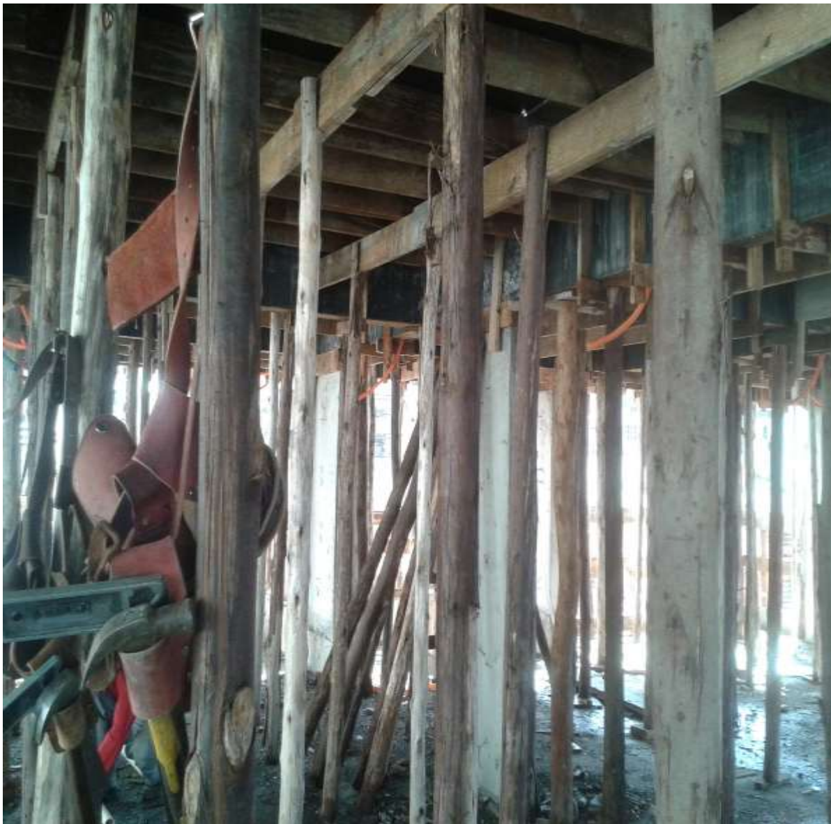
Figura 5: Escoramento de forma de LMS Fonte: Adquirida pelos autores.
