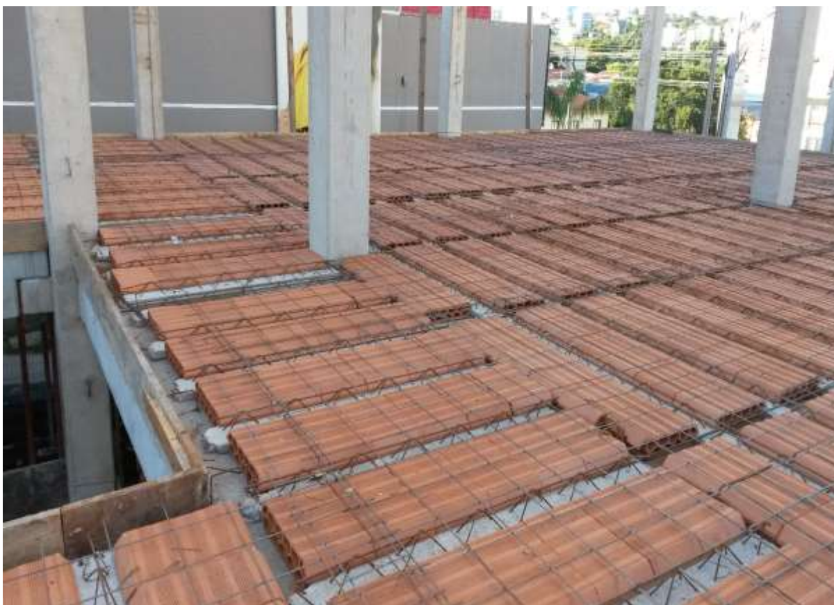
Figura 16: Malha de aço sobre as vigotas e tabelas – Edifício LVPT Fonte: Adquirida pelos autores.
