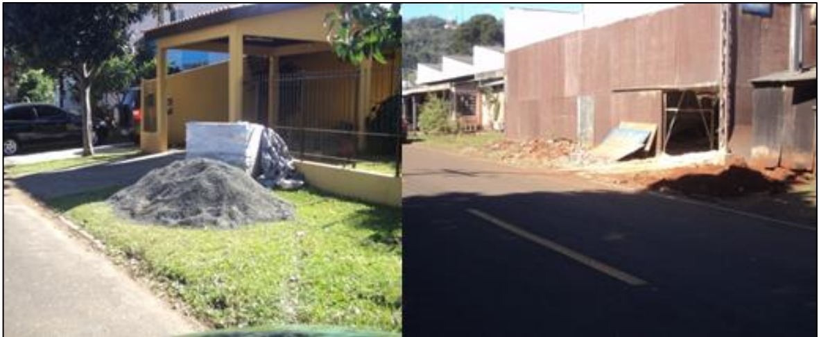
Figura 17 - Armazenamento inadequado de materiais de construção Fonte: A autora, 2014.
