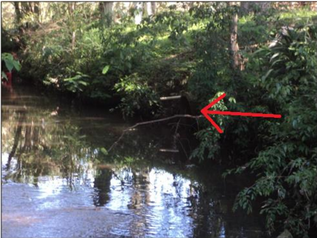
Figura 20 - Tubos de Esgoto Fonte: A autora, 2014.
