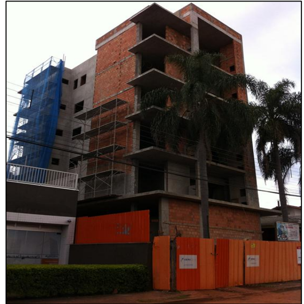
(b) Fase da construção em 13 jul. 2013
