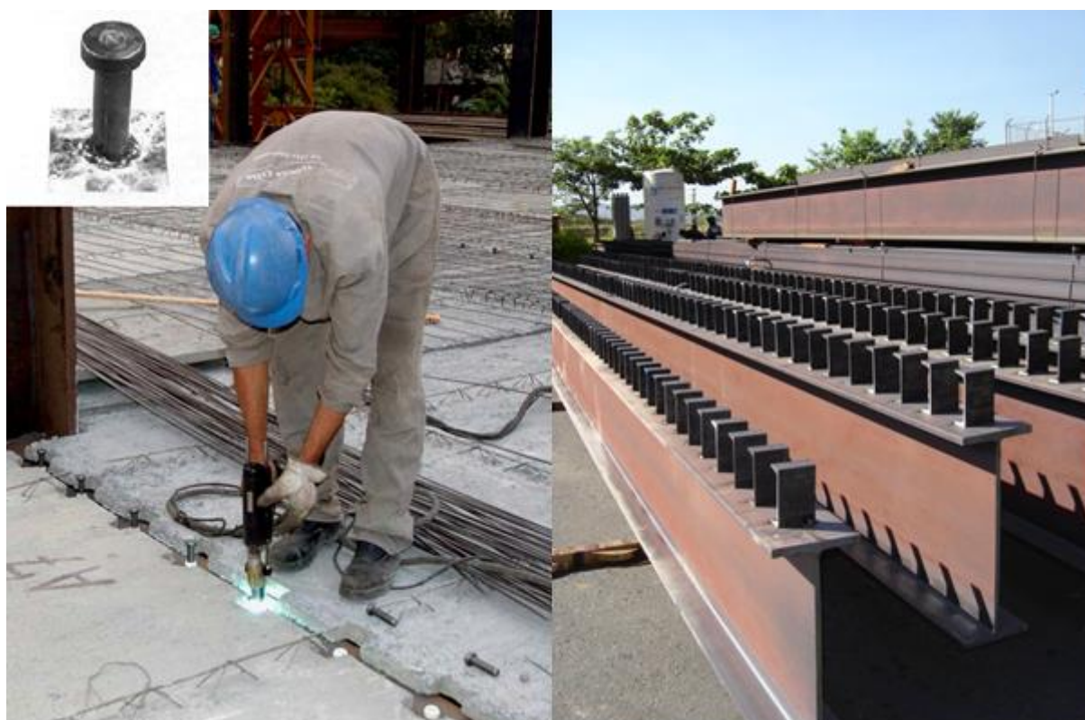
Figura 15 - Tipos de conectores de cisalhamento Fonte: Souza (2014).
