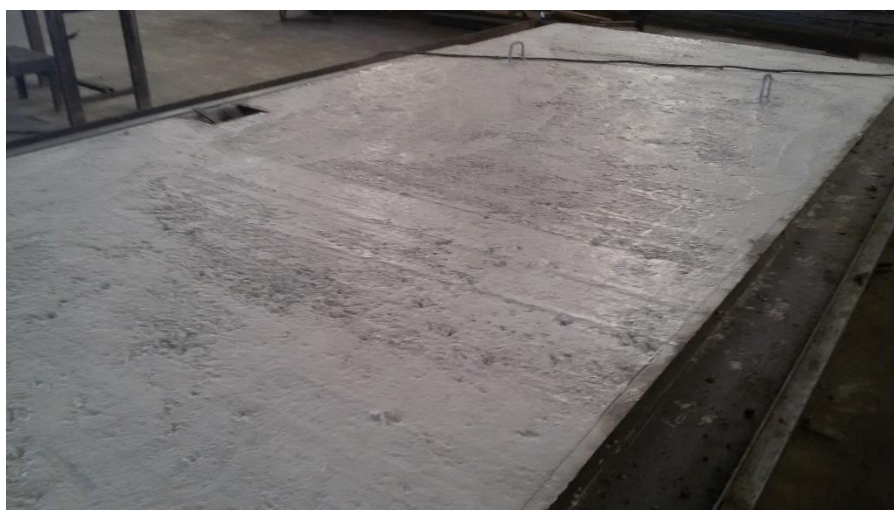
Figura 18: Elemento pré-moldado no estado endurecido Fonte: Autoria própria, 2016.
