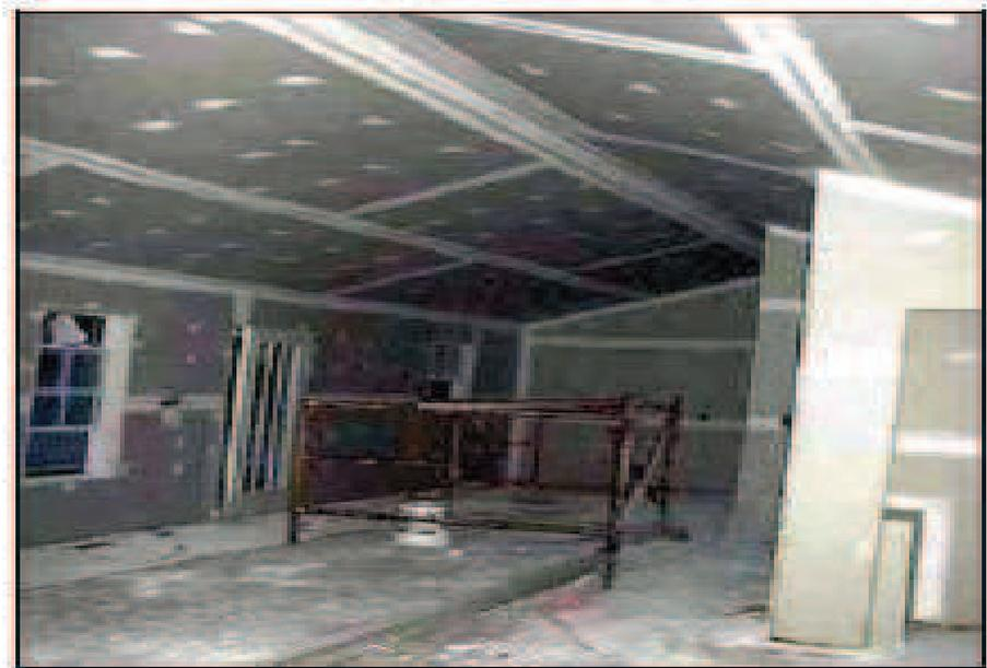
**Figura 18: Construção com fechamento de placa cimentícia.**
