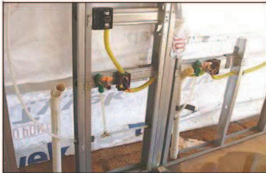
**Figura 19: Paredes em Steel Framing com instalações elétricas e hidráulicas**
