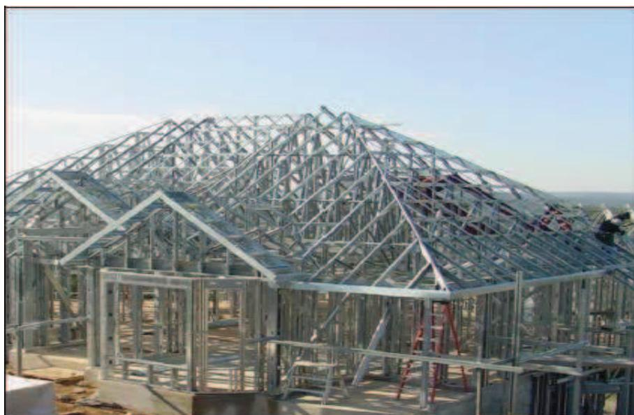
**Figura 5: Construção em Steel Framing.**
