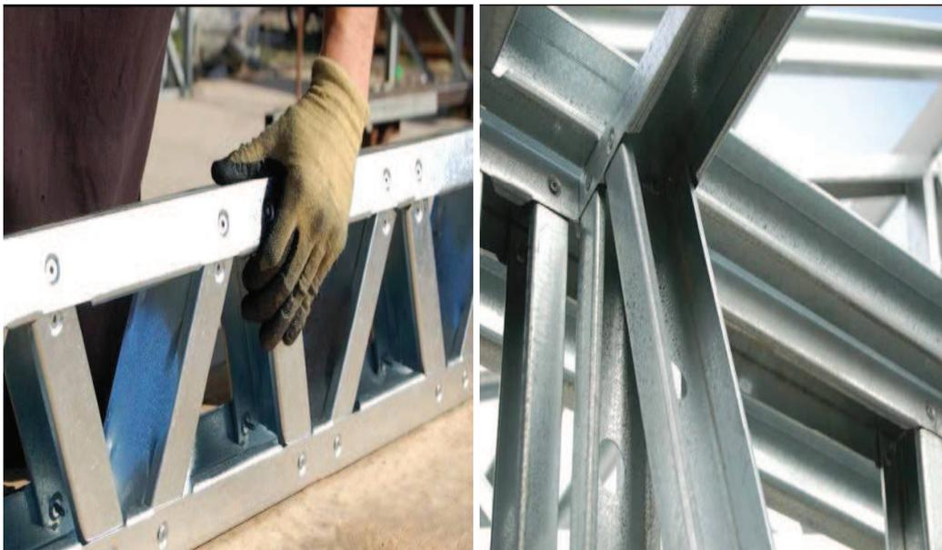
**Figura 6: Detalhes da montagem de estruturas de Light Steel Framing**
