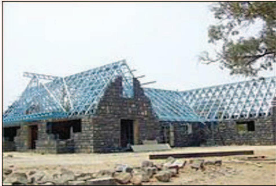
**Figura 22: Estrutura de cobertura em steel frame para edificação convencional**
