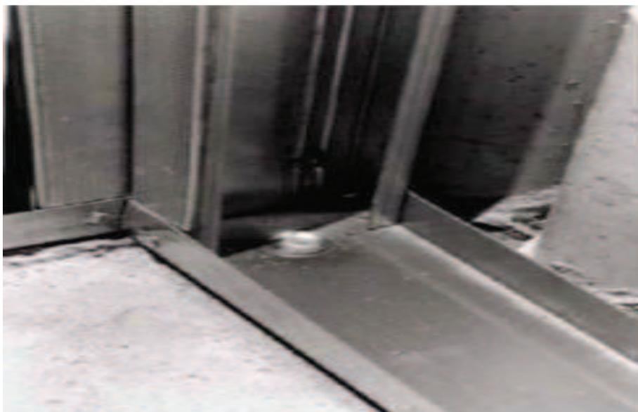
**Figura 8: Ancoragem provisória**
