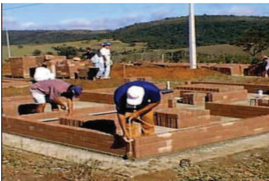
**Figura 3: Construção em Sistema Convencional**
