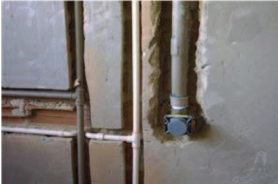
**Figura 4: Instalações embutidas na alvenaria**
