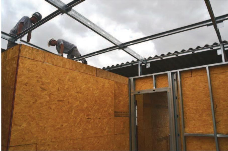
**Figura 16: Fechamento de parede em steel framing**
