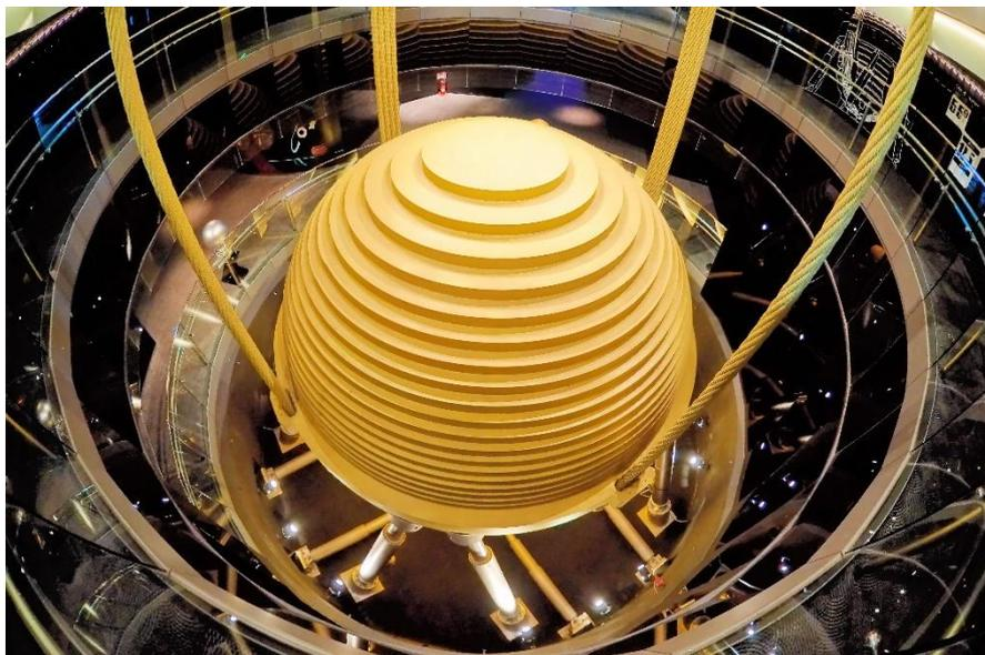
Figura 7.-. Atenuador do tipo pendular instalado no edifício Taipei 101
