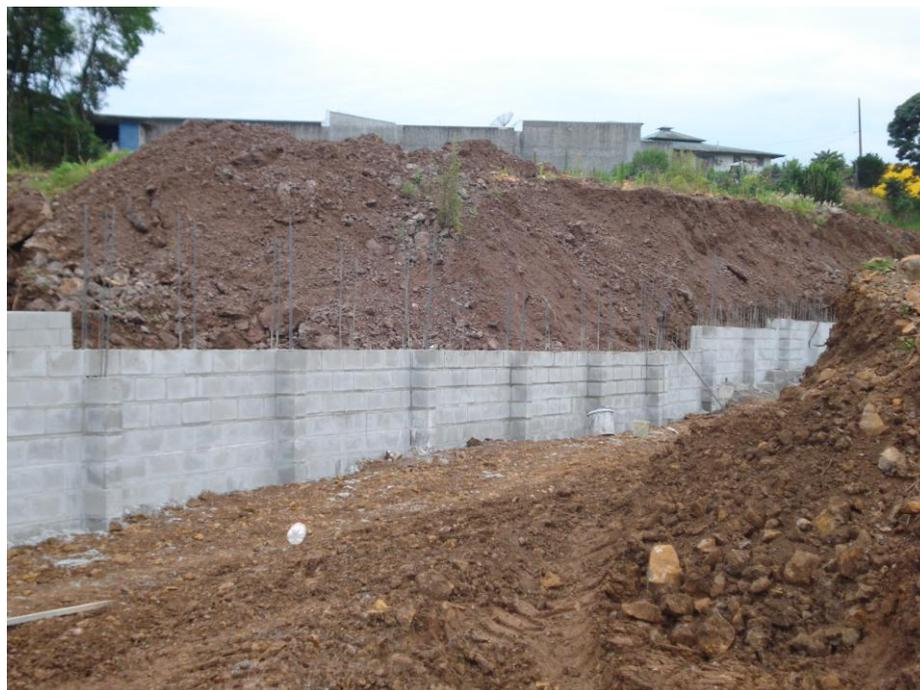
**Figura 4 – Muro de alvenaria estrutural com contrafortes**
