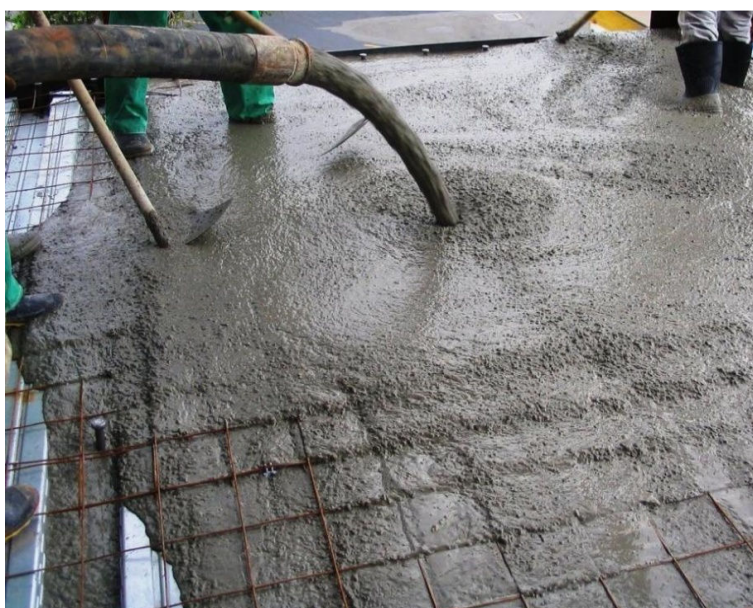
Figura 1: Lançamento de concreto auto-adensável Fonte: FARIA, 2008
