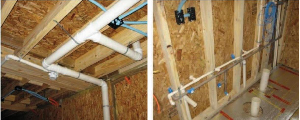
**Figura 30 – Instalações Hidrossanitárias Wood Frame**
