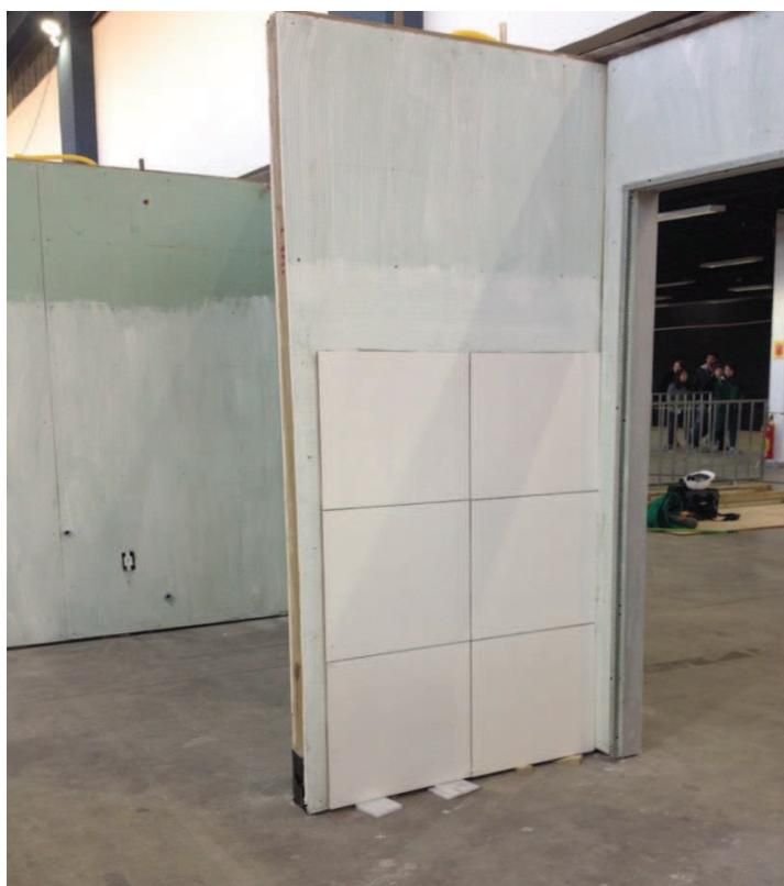
**Figura 34 – Azulejo colocado sobre a placa de gesso**
