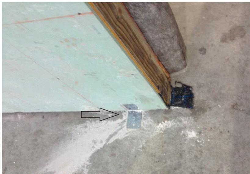
Figura 15 – Exemplo de placa metálica fixadora do painel na fundação
