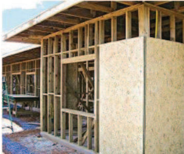
**Figura 12 – Contraventamento externo com chapas de OSB**
