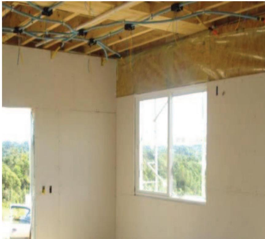
**Figura 31 – Instalações Elétricas wood frame.**
