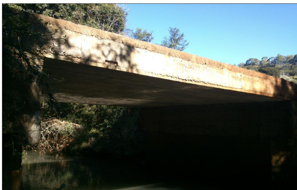
Figura 9 – Ponte sobre o Rio Caçador em Vitorino-PR Fonte: Os Autores (2014).
