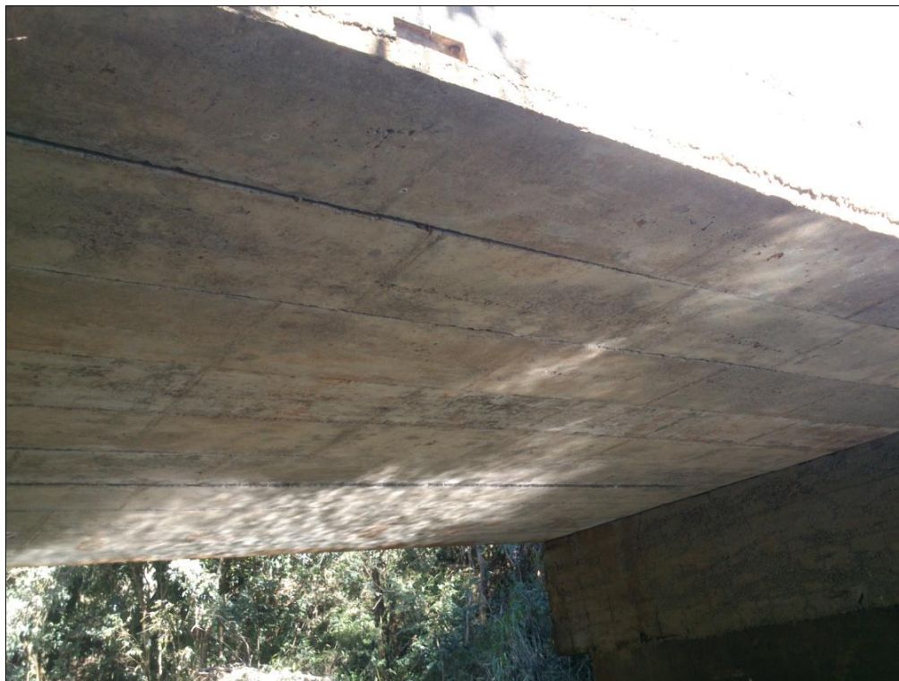
Figura 10 – Ponte sobre o Rio Caçador em Vitorino-PR Fonte: Os Autores (2014).
