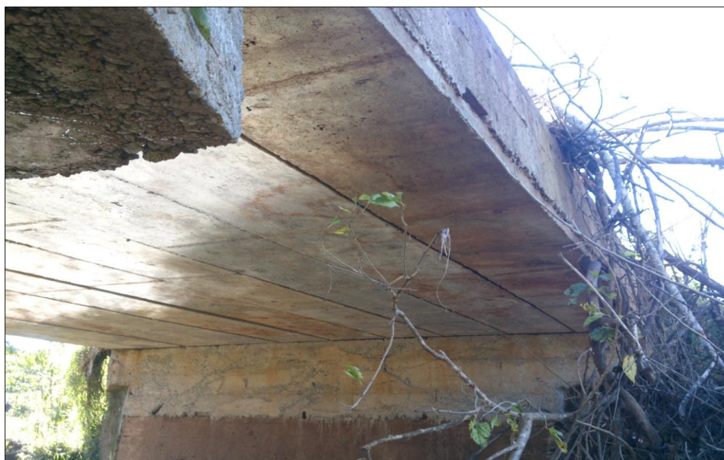
Figura 13 – Ponte sobre o Rio Vitorino Fonte: Os Autores (2014).
