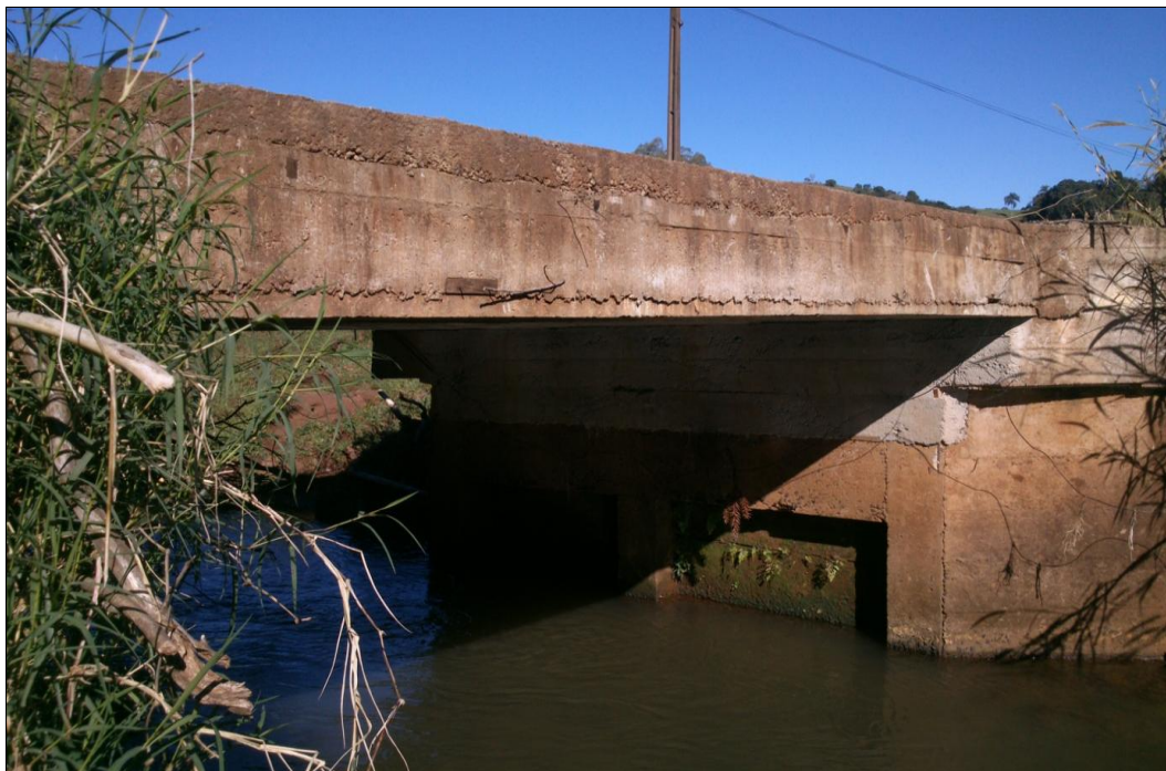
Figura 12 – Ponte sobre o Rio Vitorino Fonte: Os Autores (2014).
