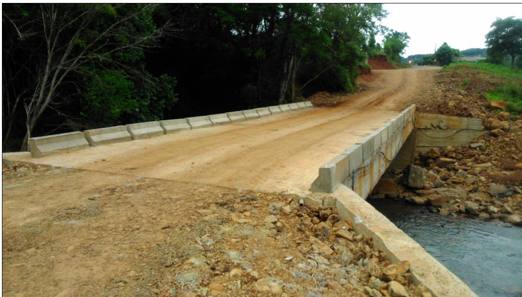
Figura 16 – Ponte sobre o Rio Capanema Fonte: Os Autores (2014).
