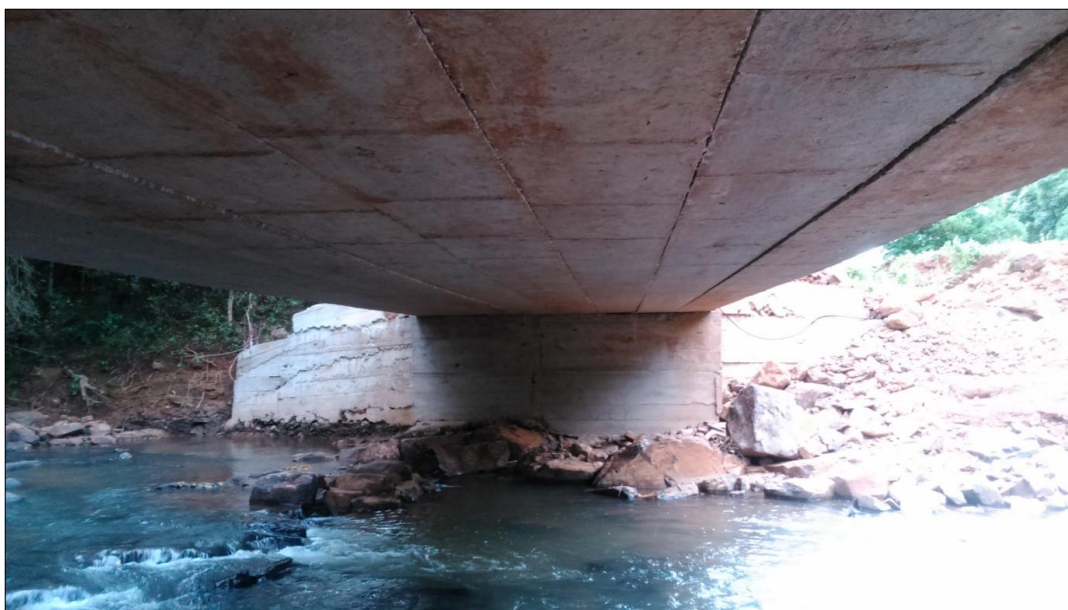
Figura 17 – Ponte sobre o Rio Capanema Fonte: Os Autores (2014).
