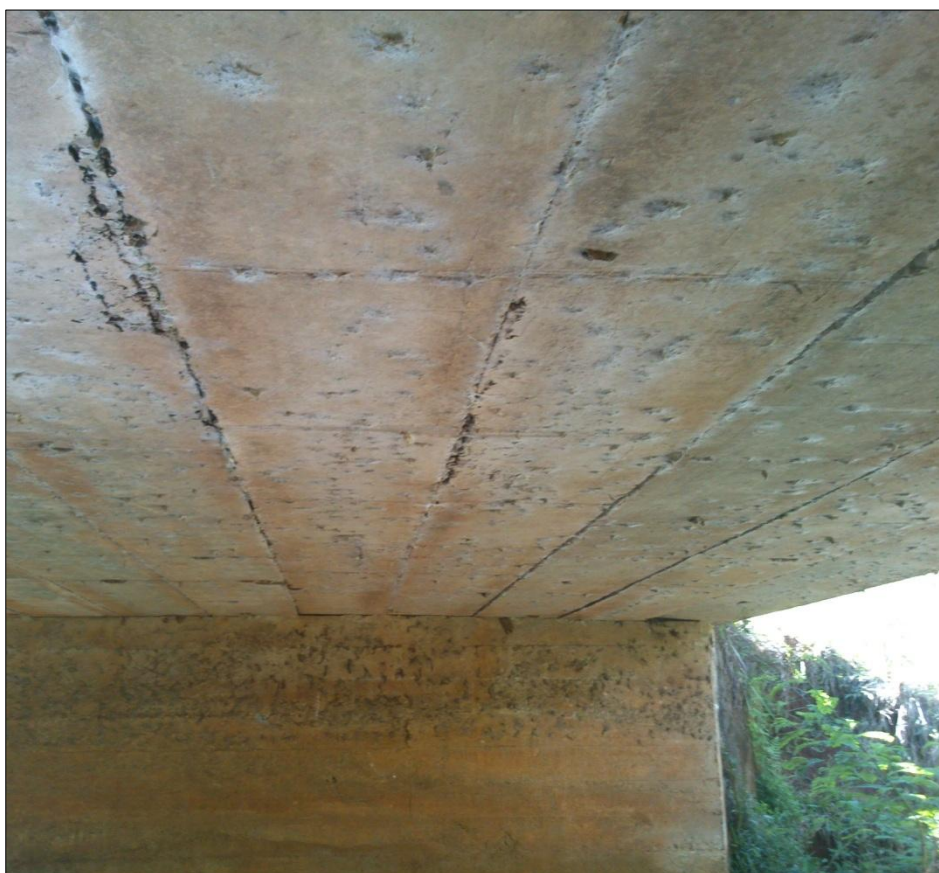
Figura 14 – Ponte sobre o Rio Independência Fonte: Os Autores (2014).
