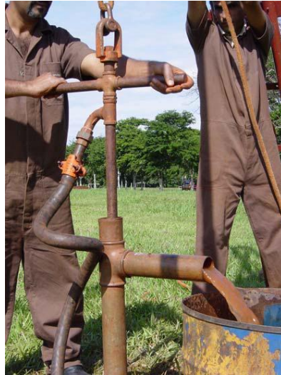
Figura 4 – Trépano com circulação de água. Fonte: Belicanta (2004 apud SILVA 2008)
