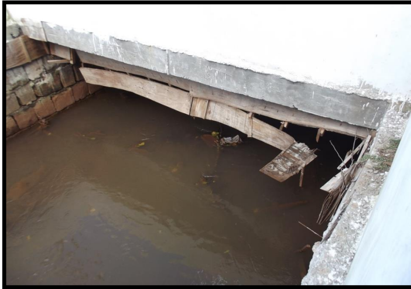
Figura 27 - Trecho do Córrego da Várzea com canalização total Fonte: Autores, (2013).
