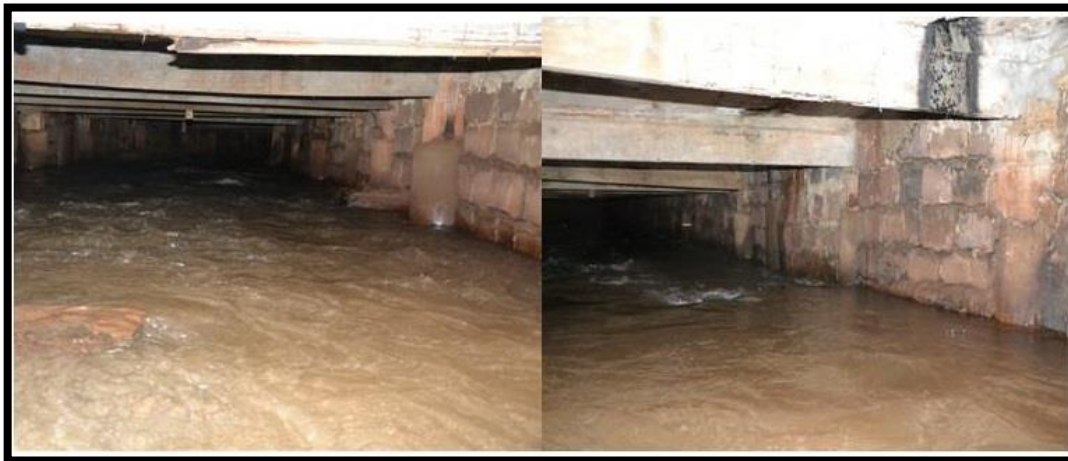
Figura 29 - Estrangulamento do canal após a junção dos dois leitos Fonte: Autores, (2013).
