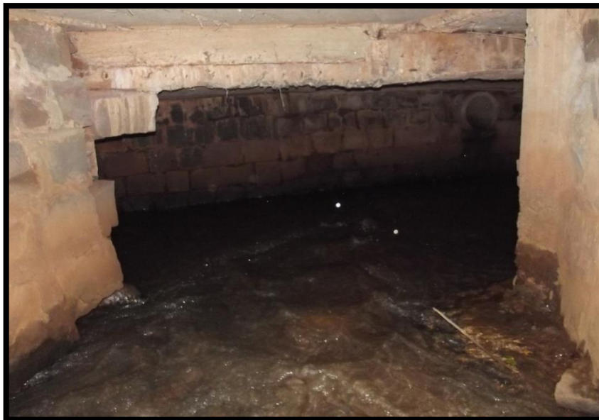
Figura 28 - Junção das canalizações do Rio Barro Preto e Córrego da Várzea Fonte: Autores, (2013).
