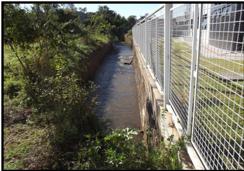
Figura 26 - Trecho do Rio Barro Preto com canalização lateral Fonte: Autores, (2013).
