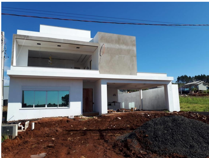
Figura 11 - Fachada Obra A Fonte: Acervo próprio (2018).
