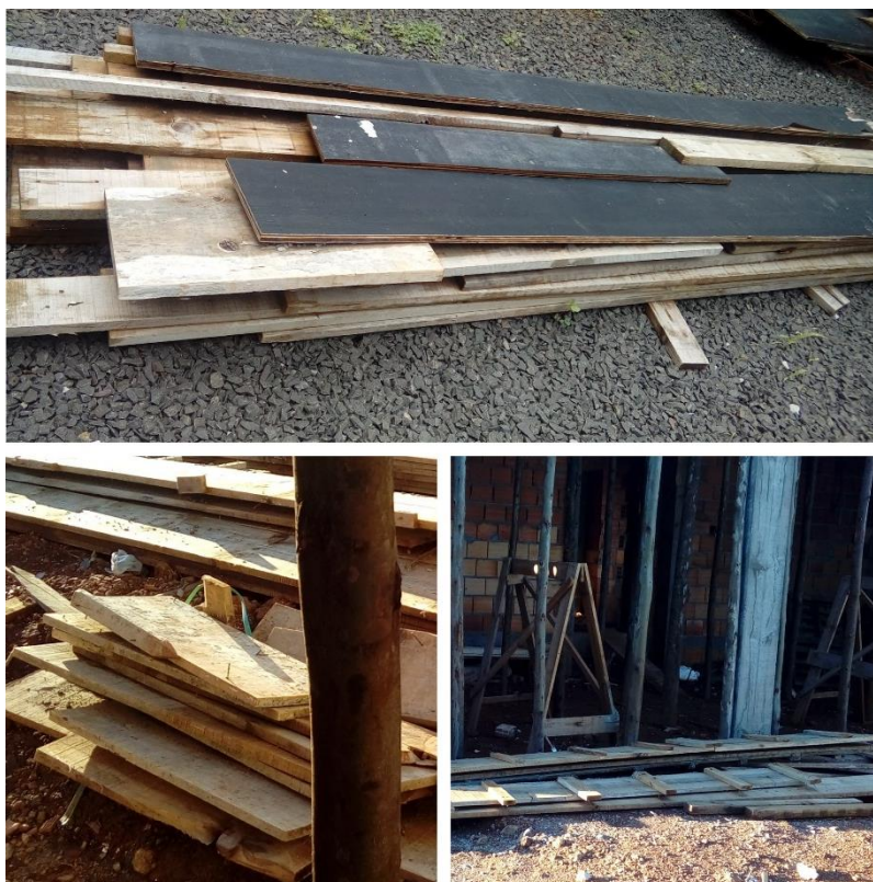
Figura 17 - Madeira após desforma Fonte: Acervo próprio (2018).
