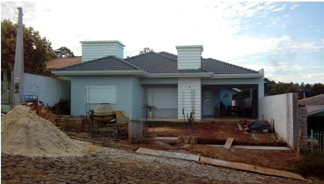
Figura 12 - Fachada Obra B Fonte: Acervo próprio (2018).
