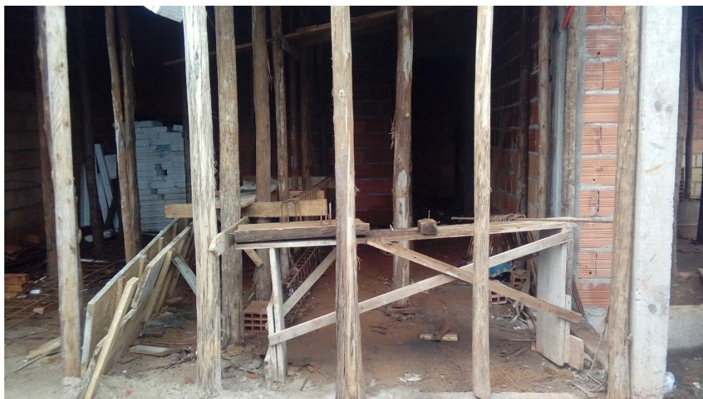
Figura 16 - Canteiro de Obras - Obra A Fonte: Acervo próprio (2018).
