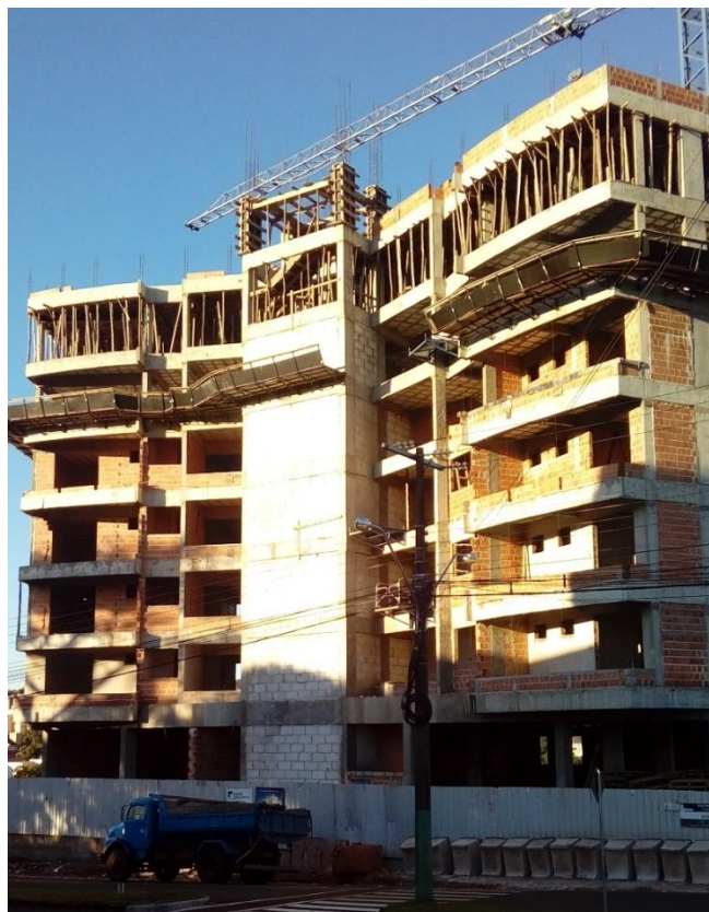
Figura 13 - Fachada Obra C Fonte: Acervo próprio (2018).
