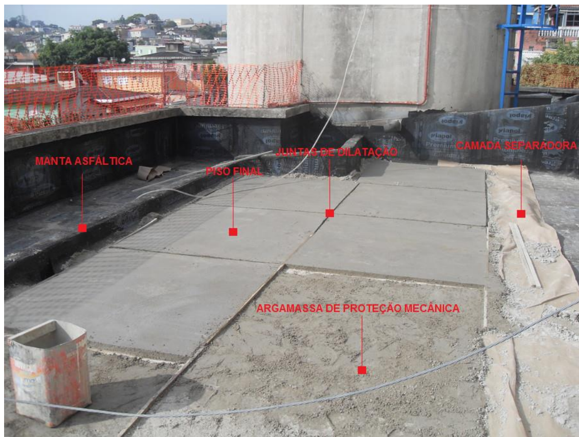
Figura 19 - Execução do Sistema de Impermeabilização Fonte: Adaptado de EIRELI (2014).
