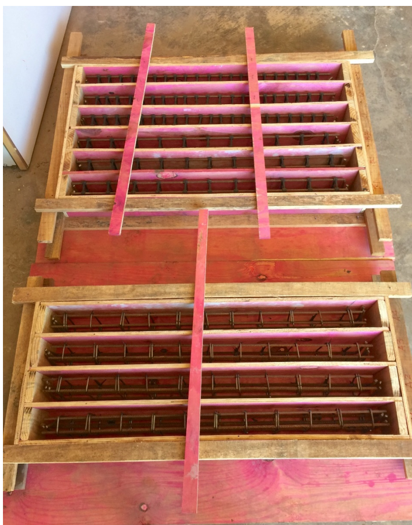
Figura 24: Detalhe das formas e armaduras Fonte: Autoria própria, 2018.
