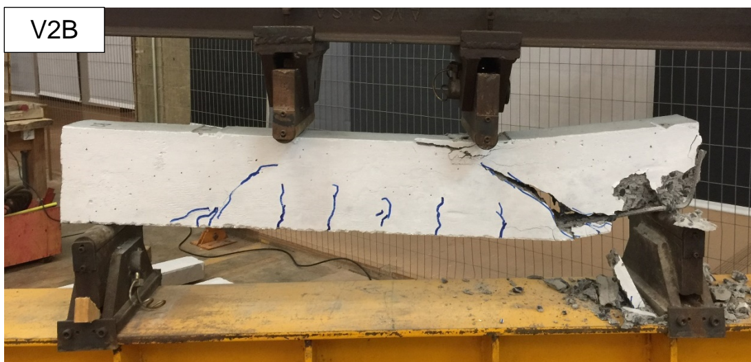
Figura 35: Padrão de fissuração - V2B Fonte: Autoria própria, 2018.
