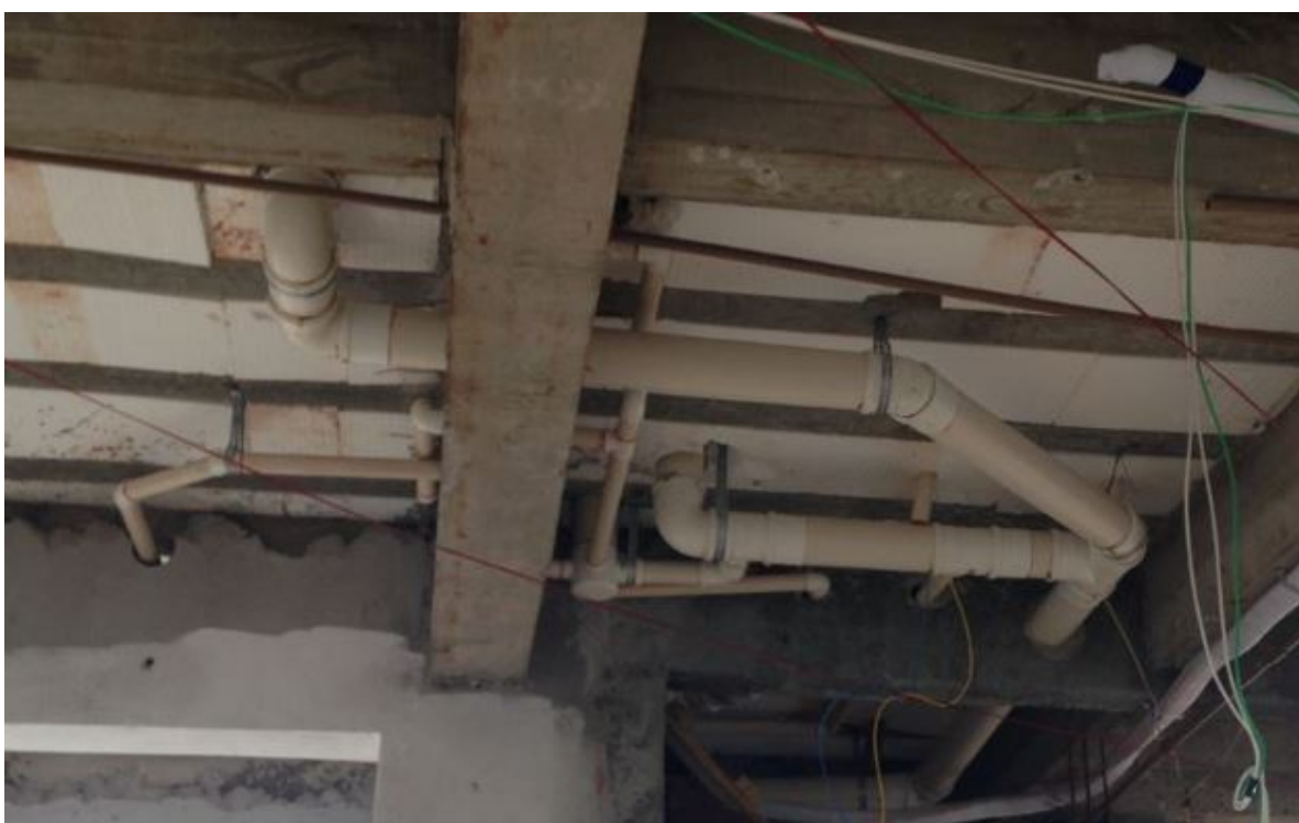
Figura 47 – Esgoto dos sanitários executado Fonte: Autor (2018).
