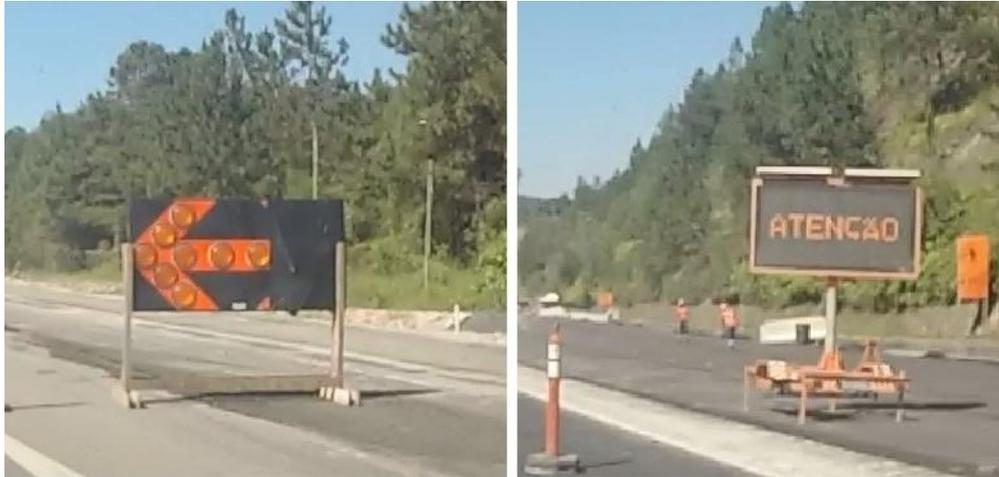
**Figura 27 - Seta luminosa e painel eletrônico.**
