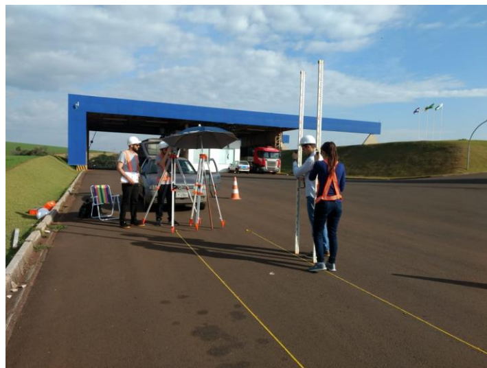
Figura 38 – Levantamento topográfico na empresa Sementes Guerra. Fonte: Própria, 2018.
